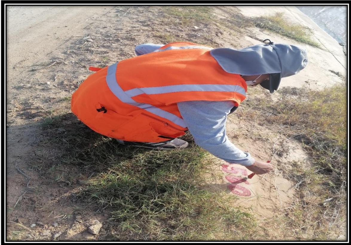
Foto 5: Colocación de los hitos durante el levantamiento topográfico.
