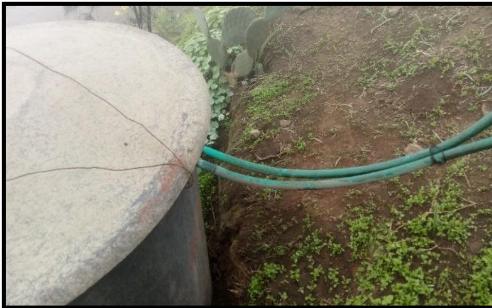
Figura 21 , Donde se almacena el agua captada con los paneles Rachel.
