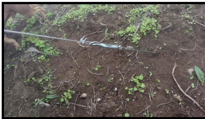
Figura 17 , tensores exteriores del panel.
