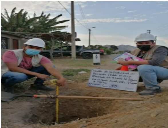
Fotografía: ejecución de calicata 10 para extracción de muestras
