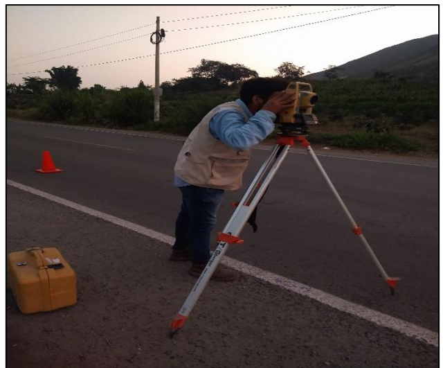
Fotografía: Toma de punto al final del tramo La Laguna Km 17.
