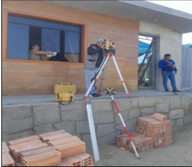
Fotografía: Configuración de estación total en el CP Rinconada Km 13.
