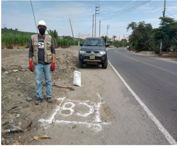
Fotografía: ejecución de calicata 8 para extracción de muestras
