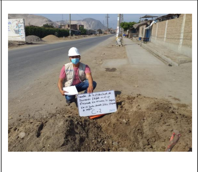
Fotografía: ejecución de calicata 2 para extracción de muestras
