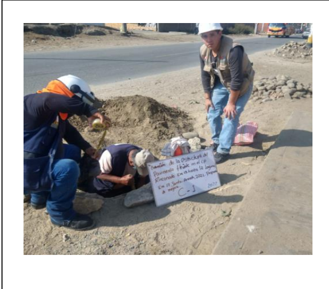
Fotografía: ejecución de calicata 1 para extracción de muestras
