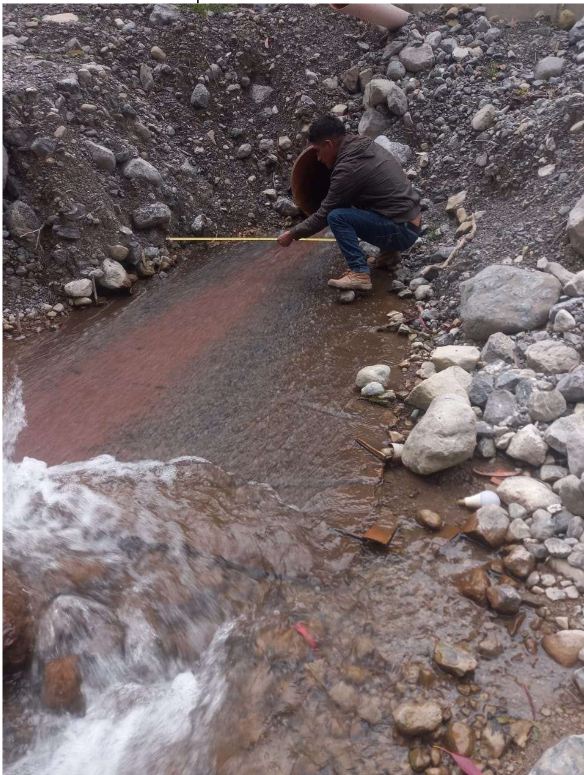
Foto 7. Medición de canal para bocatoma
