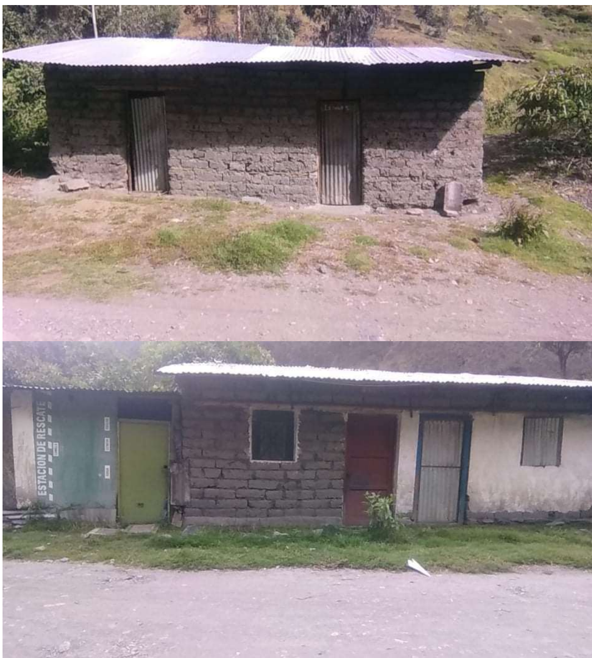
Foto 9. Viviendas en las faltas de río Quitaracsa
