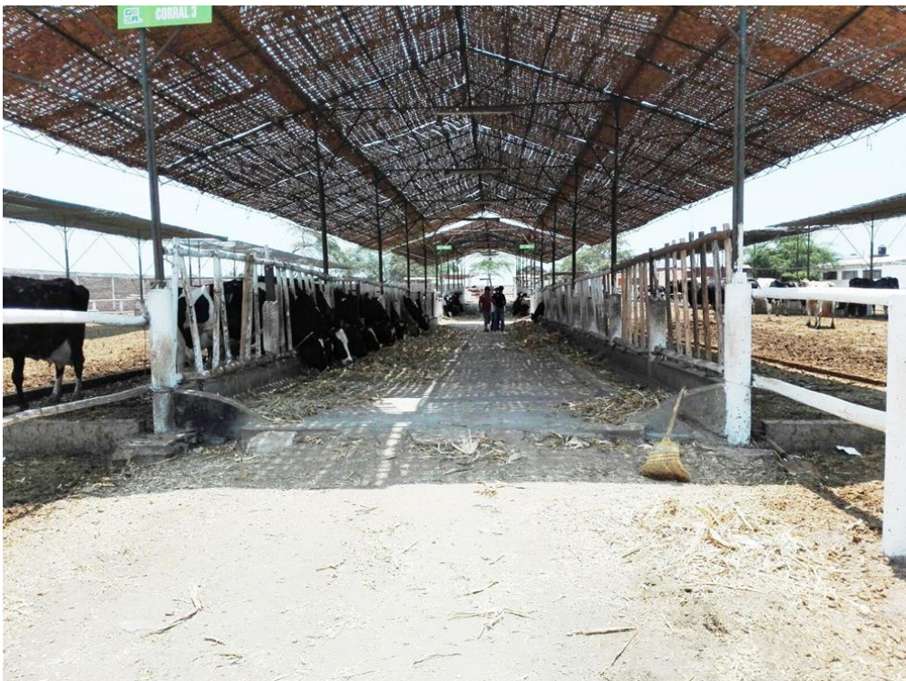
Área que será coberturada con el bombeo directo y en cuyo techo se colocaran los paneles fotovoltaicos
