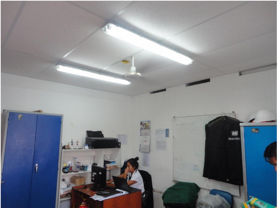
Iluminación de Aula, Edificio Electrotecnia SENATI Piura.
