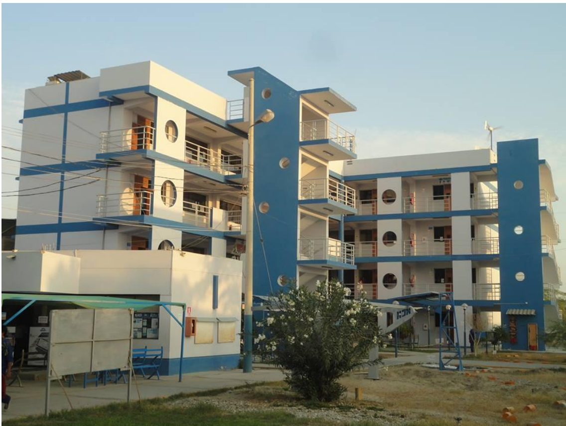
Fotografía actual del edificio de electrotecnia SENATI Piura
