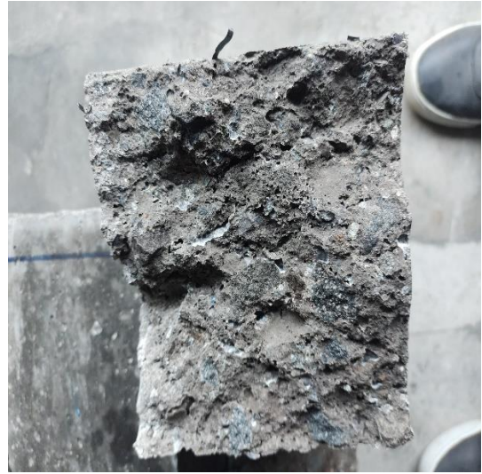
Foto 40: Viruta reciclada de acero en vigas.
