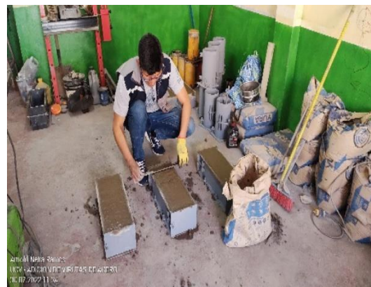
Foto 30: Enrazado de concreto en moldes de vigas.
