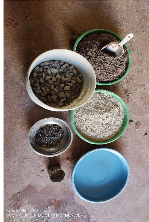
Foto 8: Insumos a utilizar para preparación de concreto.
