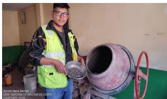
Figura 16. Incorporación de viruta en mezcla de concreto
