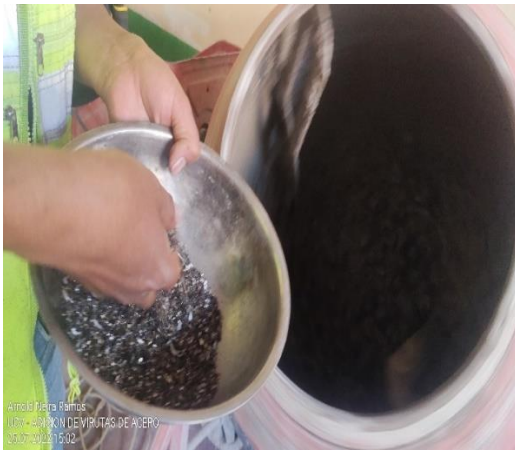
Foto 27: Incorporación de virutas de acero para vaciado de vigas.
