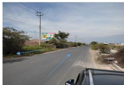
Vía eje de articulación Chiclayo_ Pimentel
