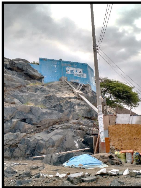
Imagen N°07: Tanque de Almacenamiento
