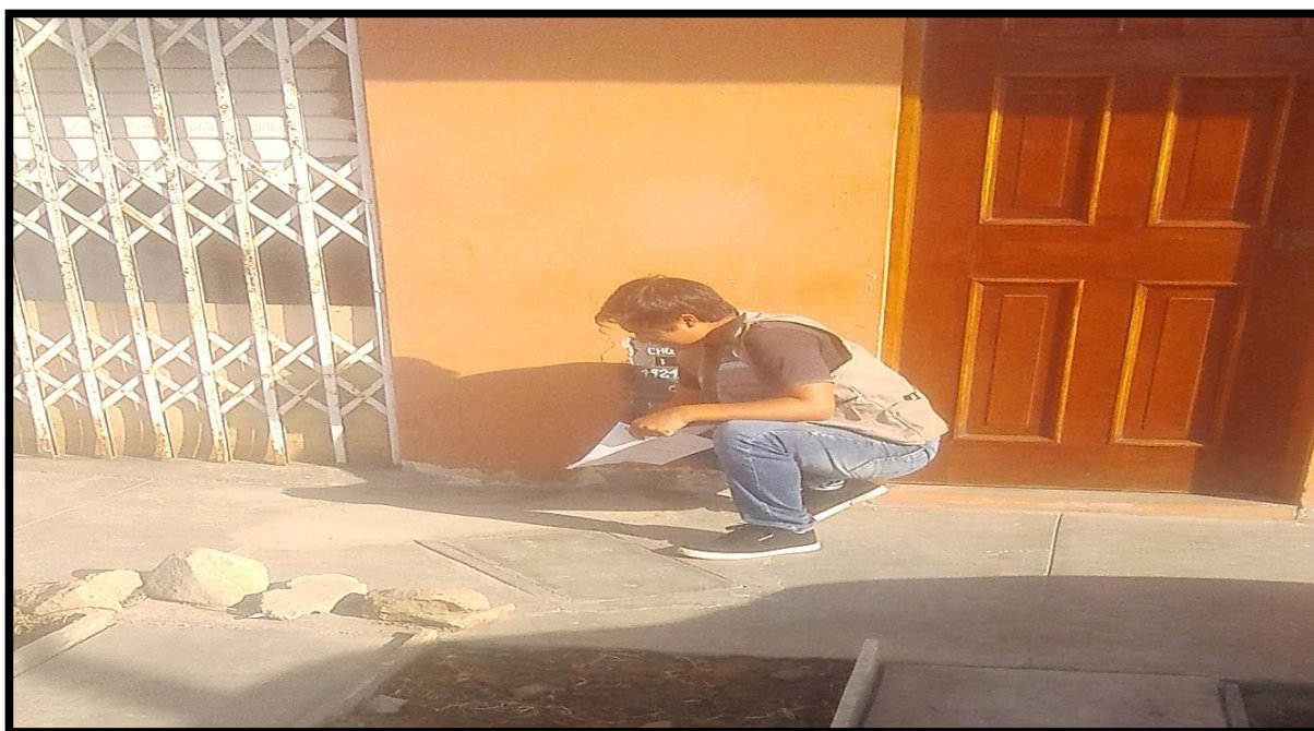
Fotografía N°05: Inspeccionando las llaves de las conexiones domiciliarias del Asentamiento Humano Villa Hermosa II Etapa.
