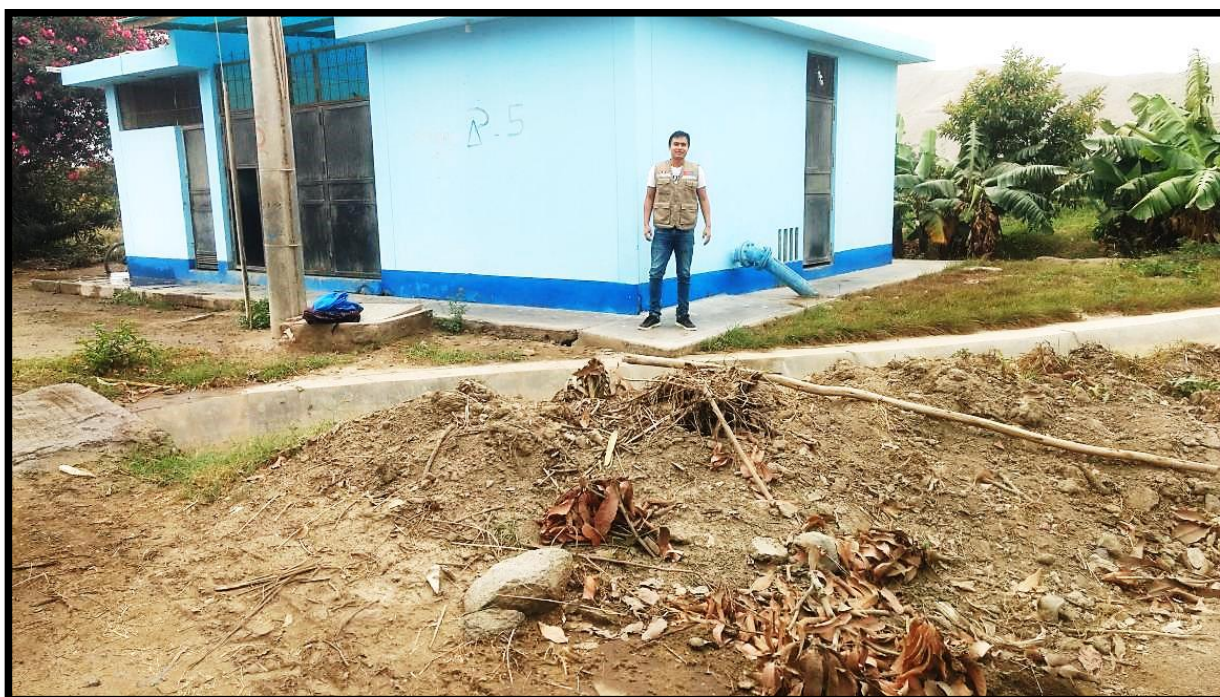
Fotografía N°14: Visita a la fuente de captación para la respectiva evaluación.
