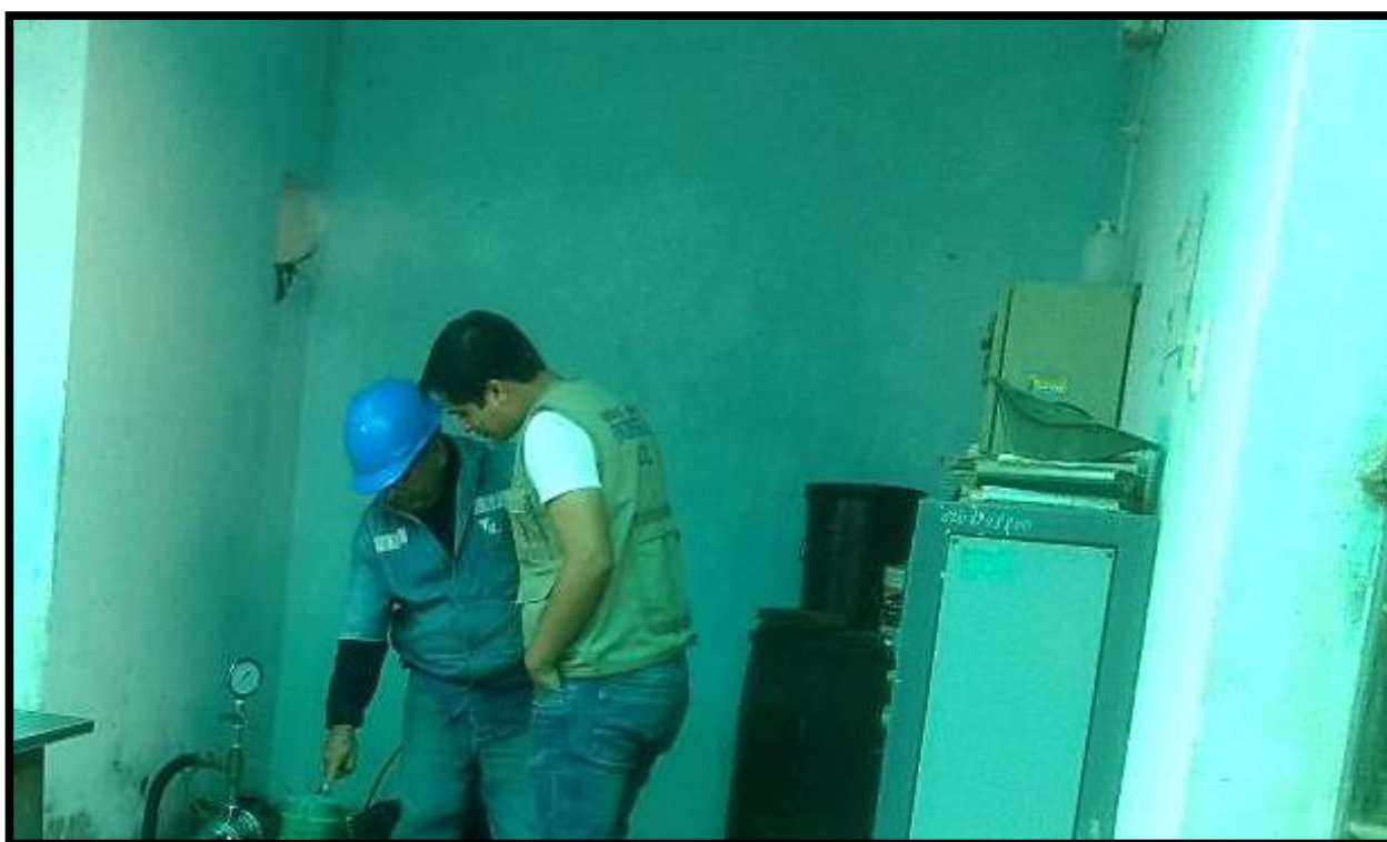
Fotografía N°16: Evaluación respectiva a la fuente de captación.
