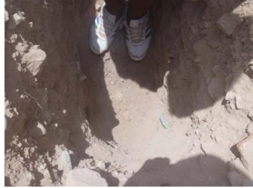
Figura 10. Apertura de calicata C-04.
