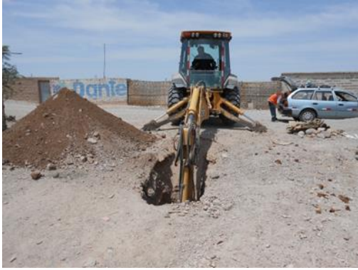
Figura 9. Apertura de calicata C-03.
