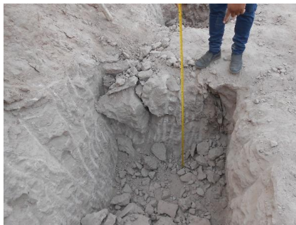
Figura 7. Apertura de calicata C-01.
