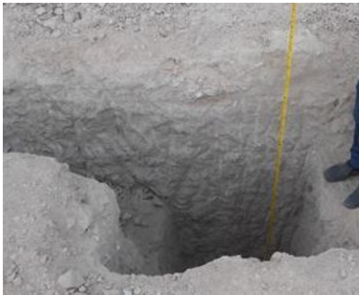
Fotografía 9: Profundidad de calicata C2
