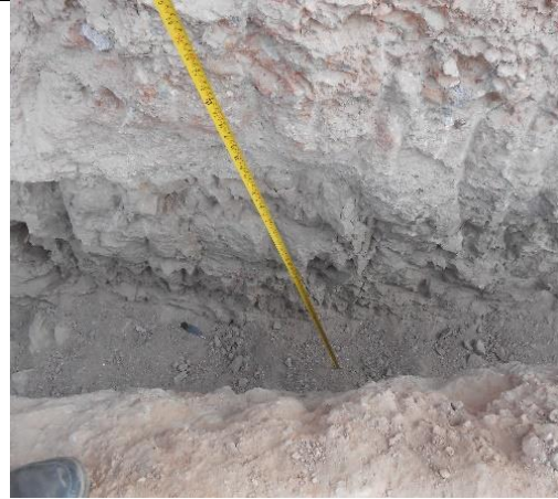
Fotografía 8: Profundidad de calicata C1
