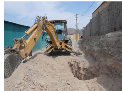
Figura 8. Apertura de calicata C-02.
