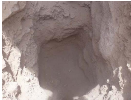
Figura 11. Apertura de calicata C-05.
