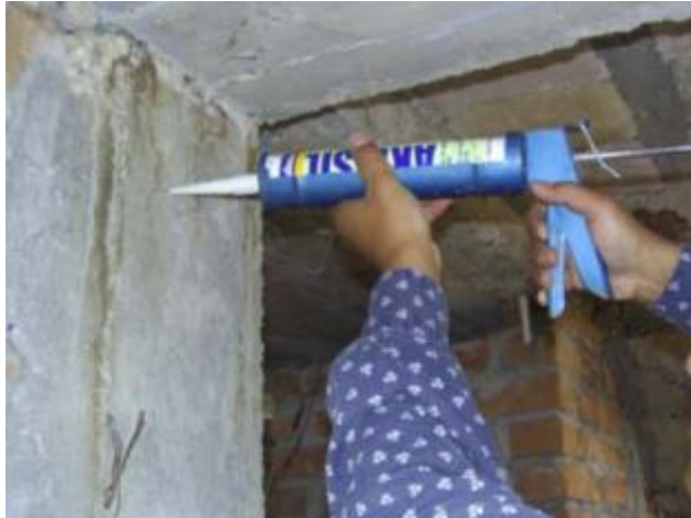
Figura 42. Inyección de resina a muro agrietado
