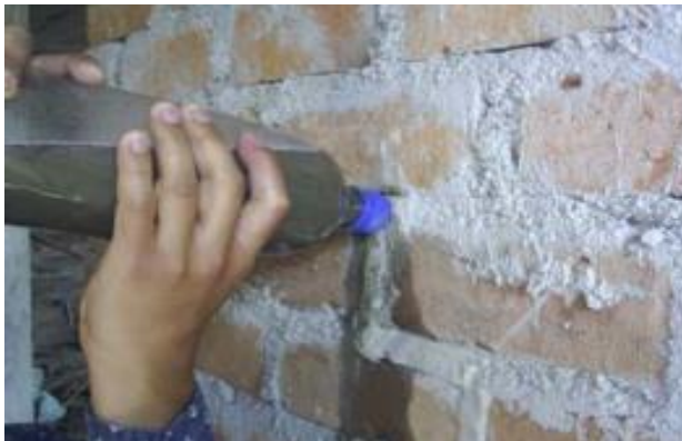
Figura 39. Insertado la lechada de cemento en grieta
