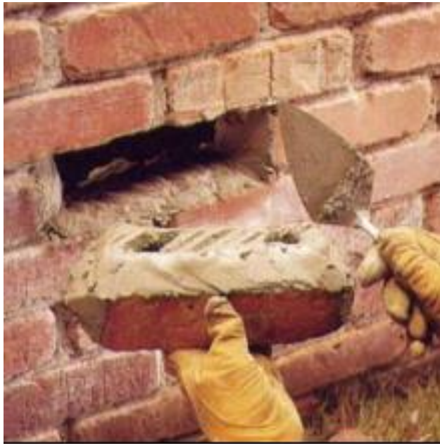
Figura 41. Reemplazo de unidades de albañilería. Black & Decker, 2000
