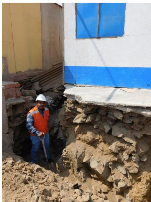
Figura 11. Vivienda sobre relleno
