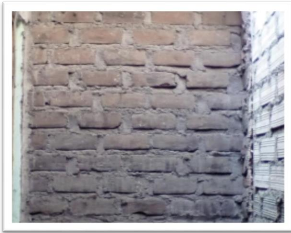
Figura 19. Ladrillos artesanales expuestos adimensionales
