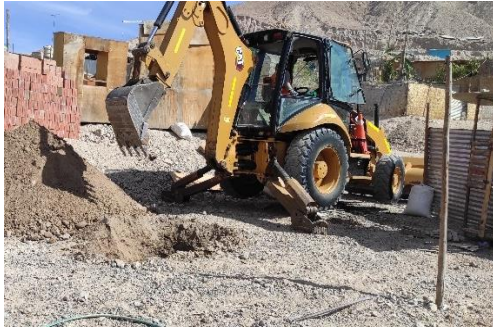
imagen 13. Excavación de Calicata C-01
