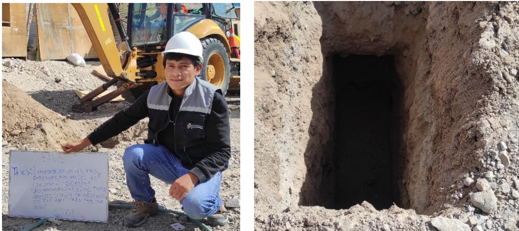
Figura 25. Calicata C-01 para Estudio de Mecánica de Suelos
