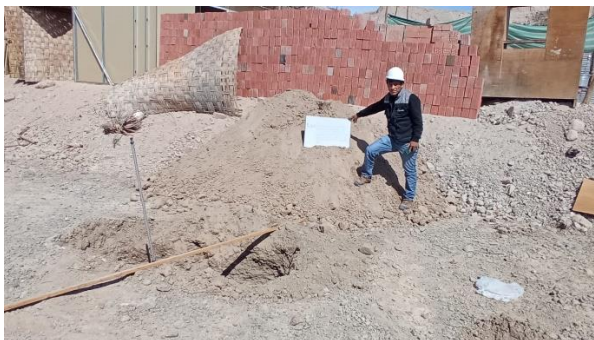
imagen 17. Material Extraído de calicata
