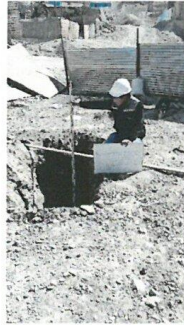
Figura N° 1.- Fotografía de excavación de la calicata C-01.
