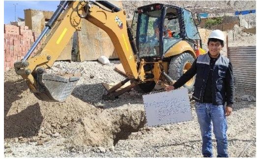
imagen 14. Excavación de Calicata
