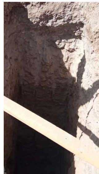
imagen 18. Vista de calicata excavada
