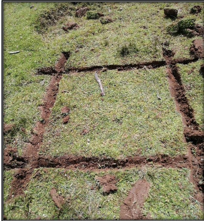
Imagen N° 1: dimensionamiento para calicatas.
