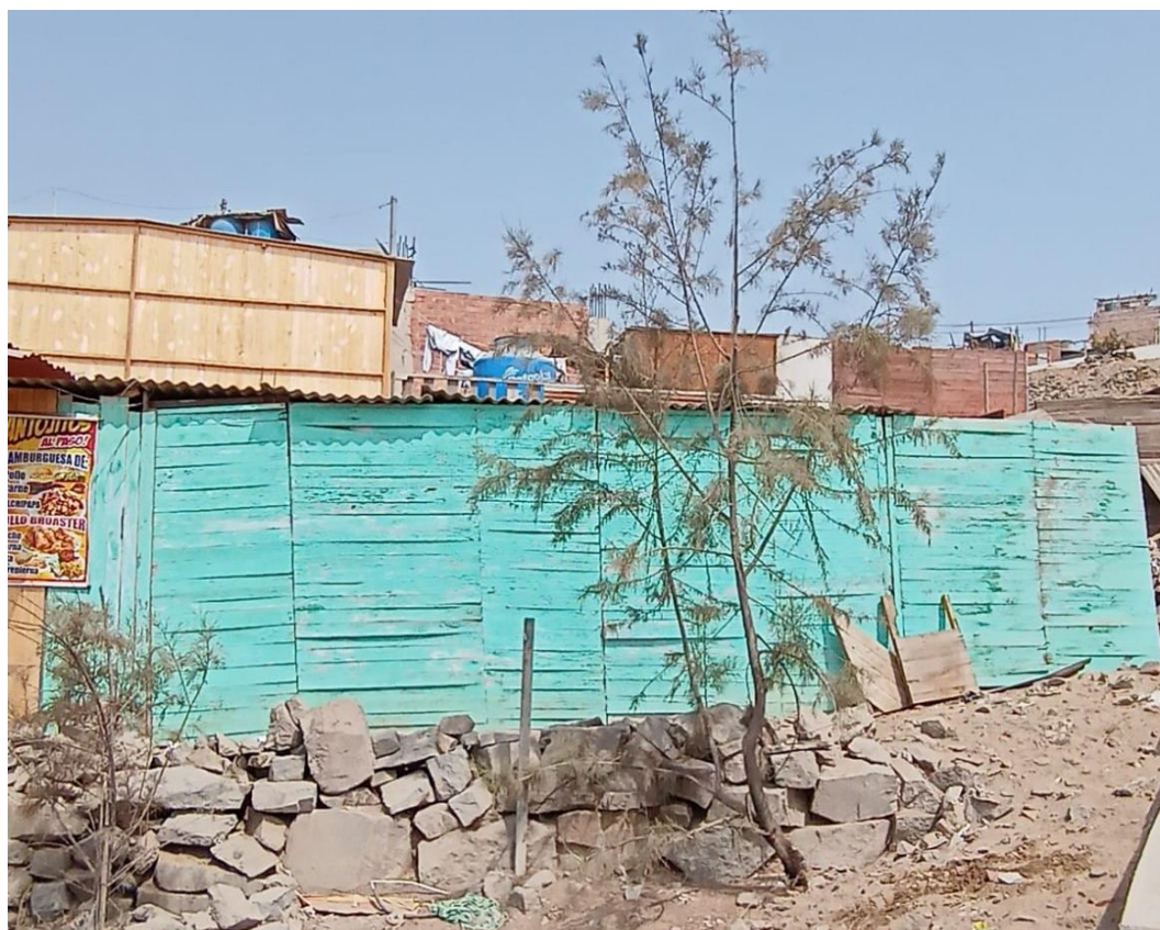
Figura 4: Construcción de la vivienda en bajas condiciones.
