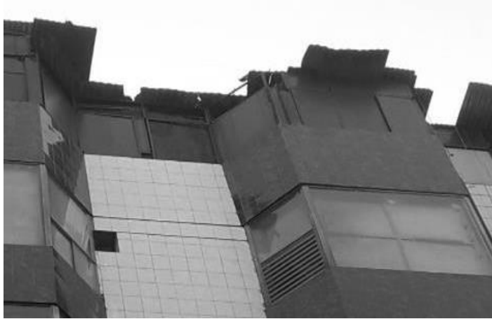
Fachada de la galería Santa Lucía
