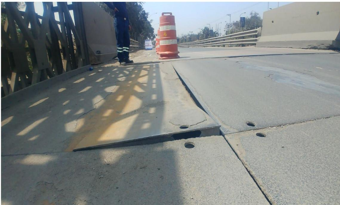
Figura 6. Puente Huaycoloro: Los tableros de la rodadura del puente HARZONE, sufren desprendimiento y doblado en la chapa de la cubierta
