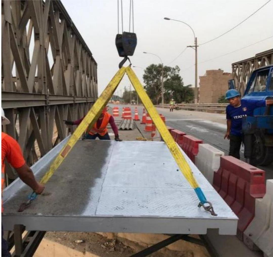
Figura 11. Puente Huaycoloro tipo Bailey: Cubierta de Canto del quinto módulo de la rodadura del puente HARZONE, es cambiado por una cubierta reparada. (puente en funcionamiento)
