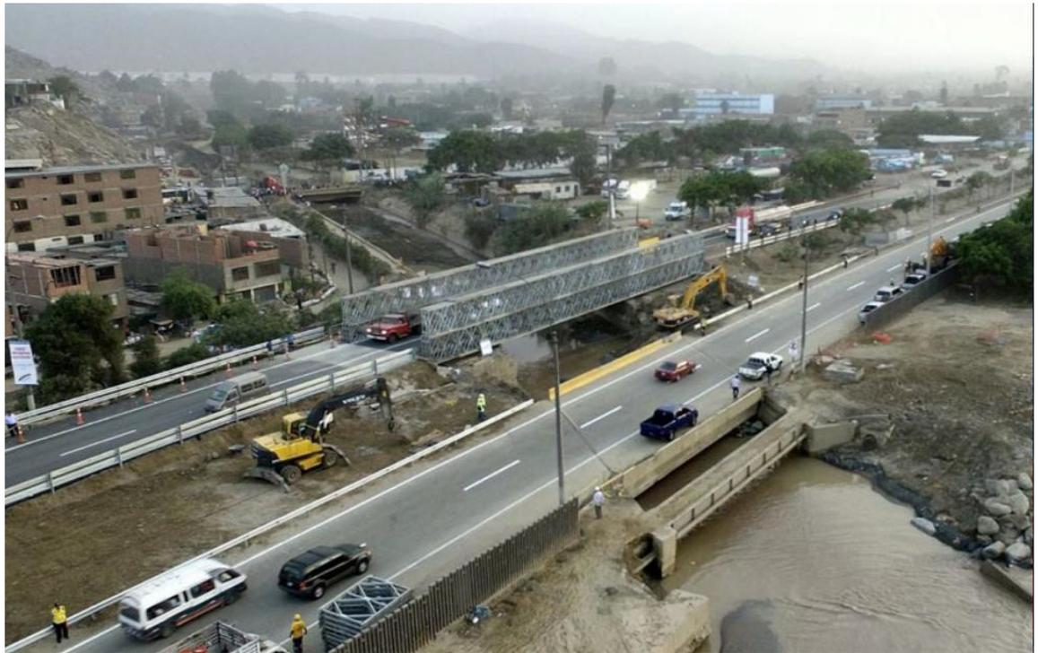
Figura 4. Puente Huaycoloro, apertura al tráfico de la nueva estructura metálica del puente tipo Bailey de la marca HARZONE china
