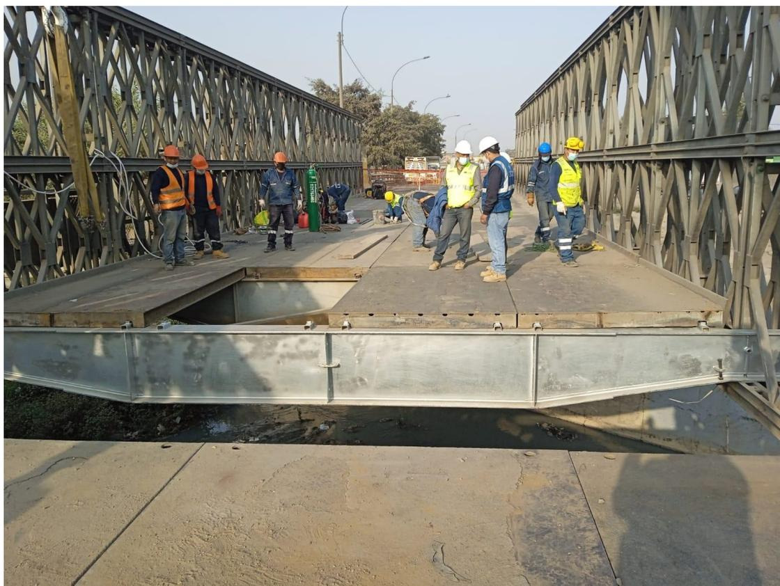
Viga transversal cambiada por otra, falta instalas sus accesorios que lo estabilicen
