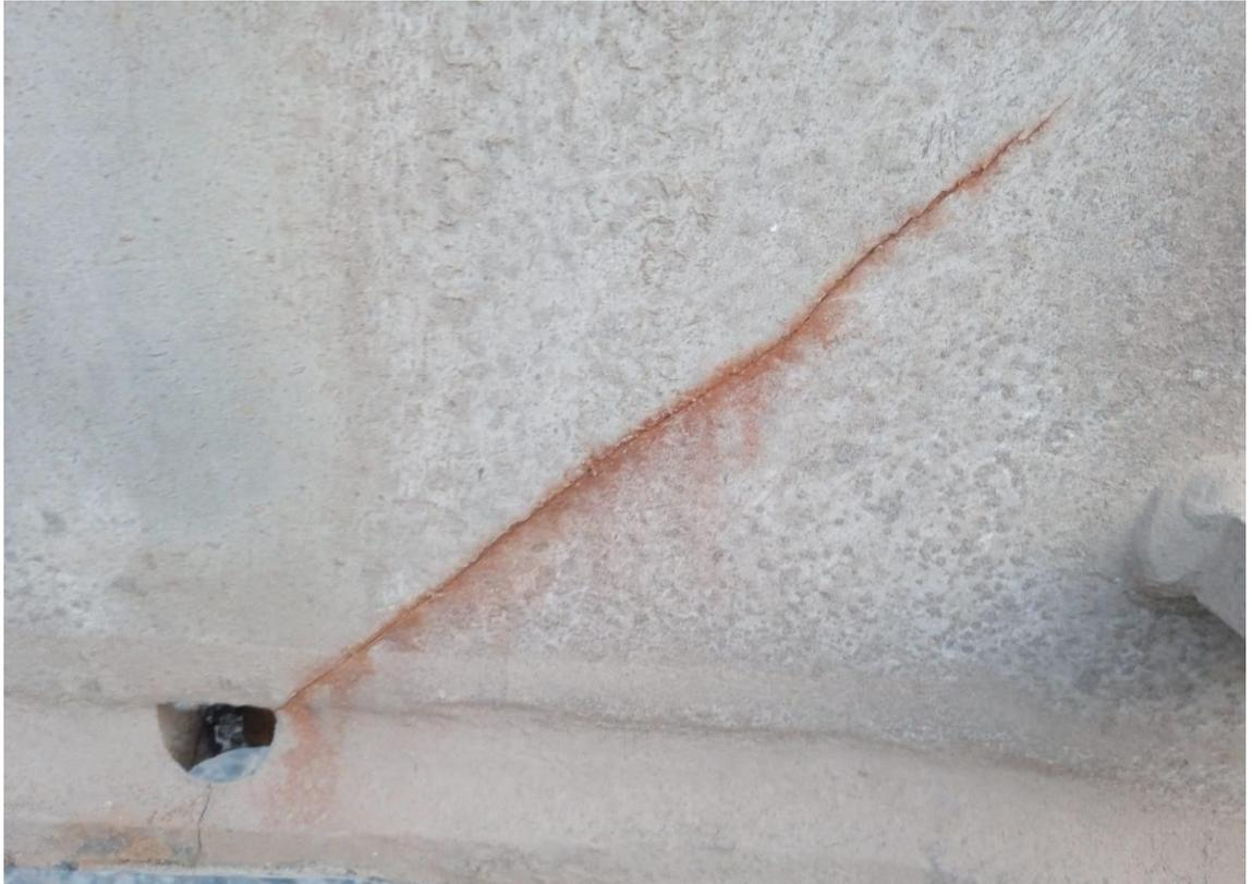
Fisuración en el alma de la viga transversal
