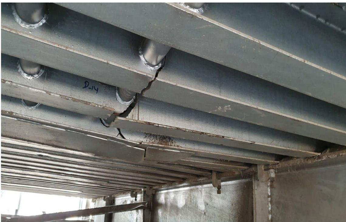
Figura 7. Puente Huaycoloro tipo Bailey: Los tableros de la rodadura del puente HARZONE, se fracturan internamente las viguetas de soporte, inclusive las chapas de amarre.
