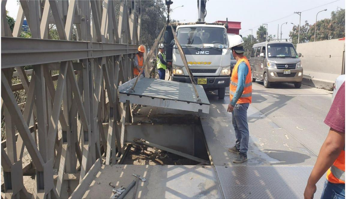
Figura 9. Puente Huaycoloro tipo Bailey: Cubierta de Canto del segundo módulo del tablero de la rodadura del puente HARZONE, es cambiado por otra cubierta reparada. (puente en funcionamiento)
