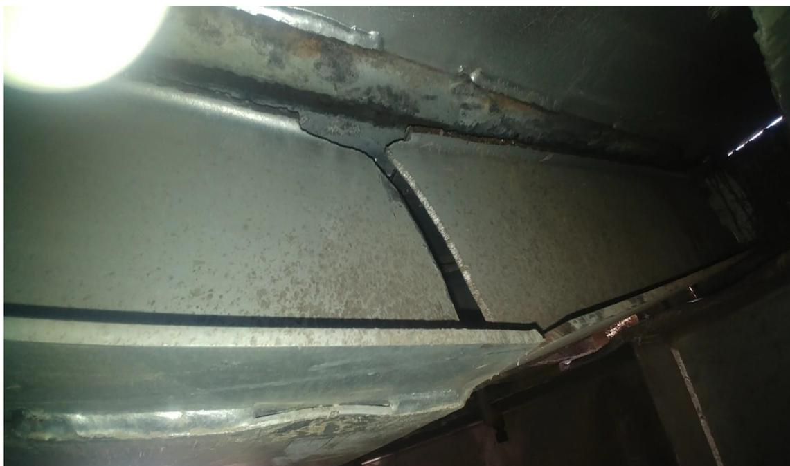
Figura 8. Puente Huaycoloro tipo Bailey: Internamente los tableros de la rodadura del puente HAR-ZONE, se puede verificar las fracturas transversales de las viguetas (el puente continúa en servicio)
