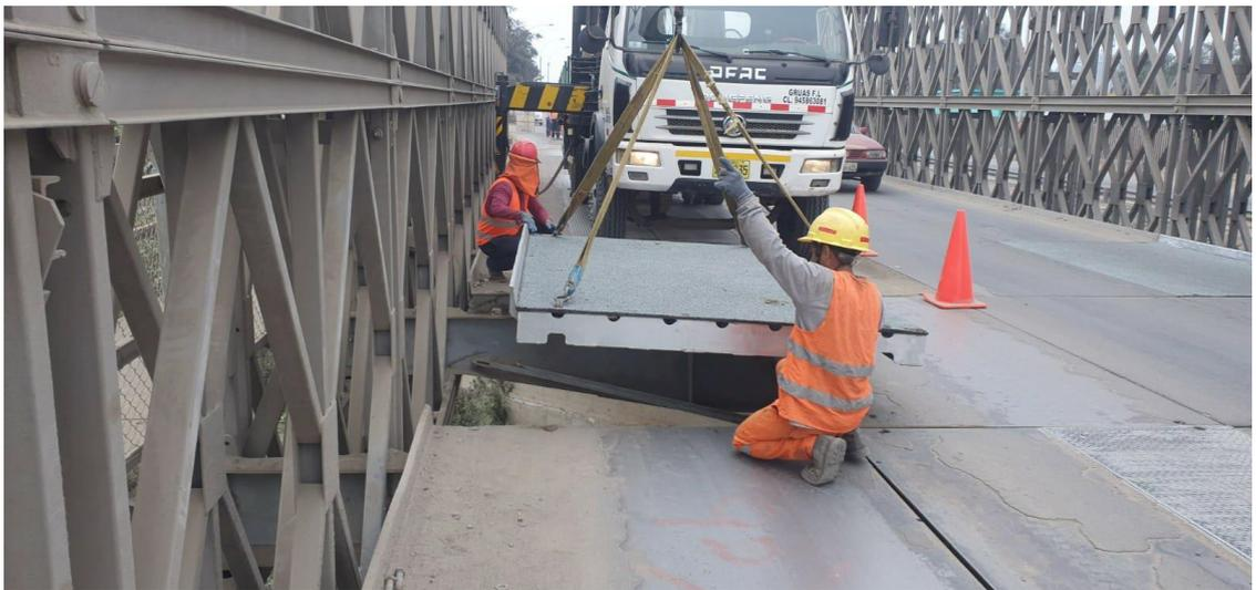
Figura 10. Puente Huaycoloro tipo Bailey: Cubierta de Canto del módulo interno de la rodadura del puente HARZONE, es cambiado por una cubierta nueva. (puente en funcionamiento)
