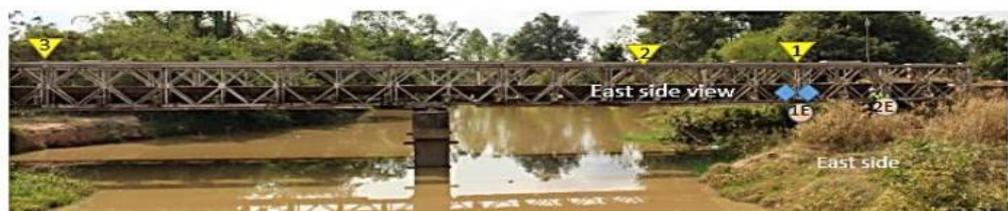
Puntos que se observan del comportamiento estático, respuestas de aceleración dirección vertical y horizontal bajo cargas de tráfico para obtener el comportamiento dinámico y las características del puente.
