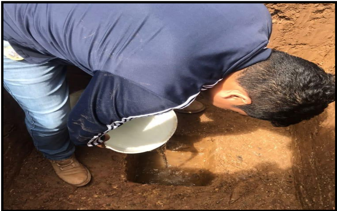
FOTO N°14 Visualización del trabajo de llenado de agua limpia.
