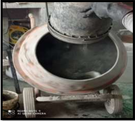
Mezclado del concreto
