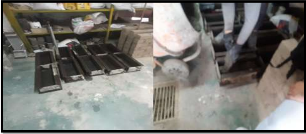
Figura 17. Llenado y compactado de vigas.
