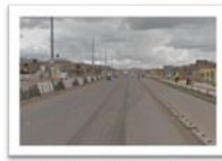
Avenida: Independencia Buena Pavimentación
