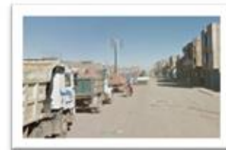
Jirón: José María Superficie Desgastada
