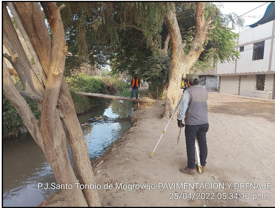
FOTO N° 20: Toma de puntos en los bordes de la acequia Cois.
