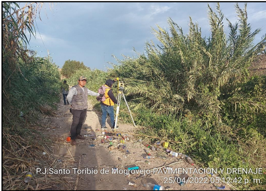
FOTO N° 19: Vista del levantamiento topográfico de la acequia Cois en el punto de desfogue del sistema de drenaje
