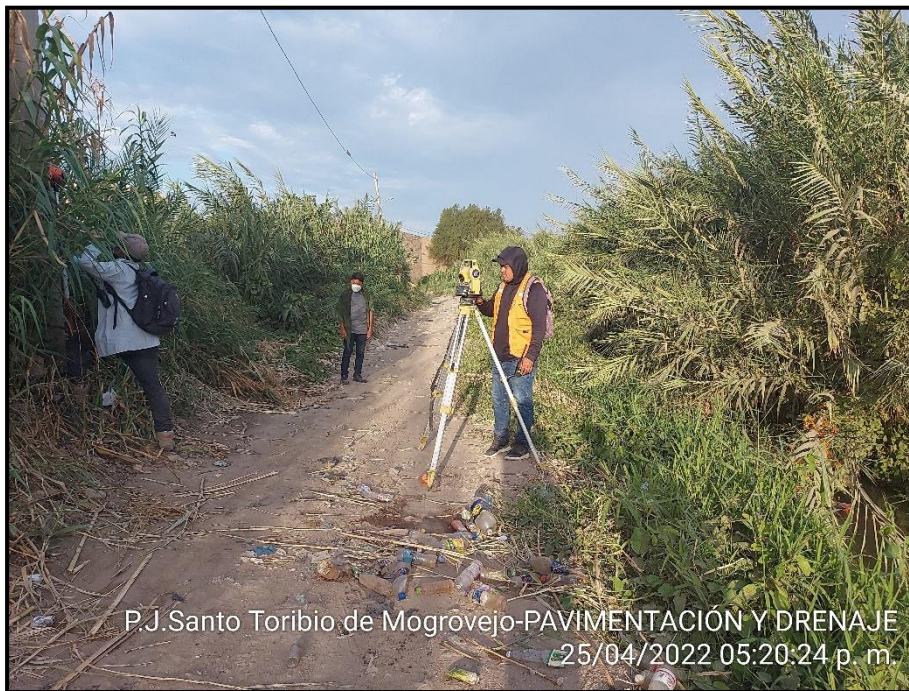
FOTO N° 20: Toma de puntos en el camino de inspección de la acequia Cois.
