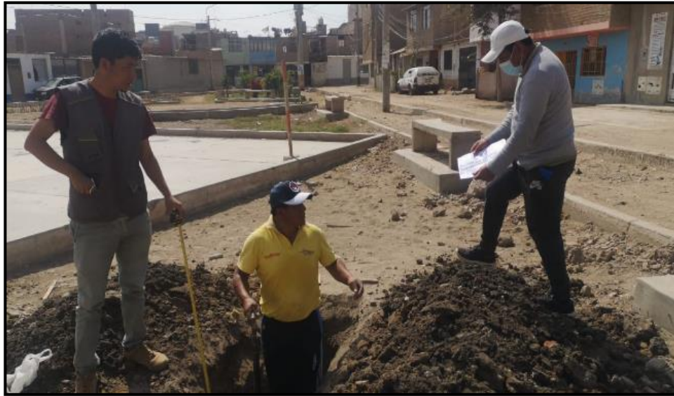
FOTO N° 11: CALICATA N°11.- Ubicada en la Calle NN - 233 -Coordenadas 9252394.42 N-625260.272 E
