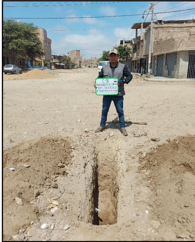
FOTO N° 5: CALICATA N°05.- Ubicada en la Calle Rio Ramis -Coordenadas 9252678.888 N-625600.604 E
