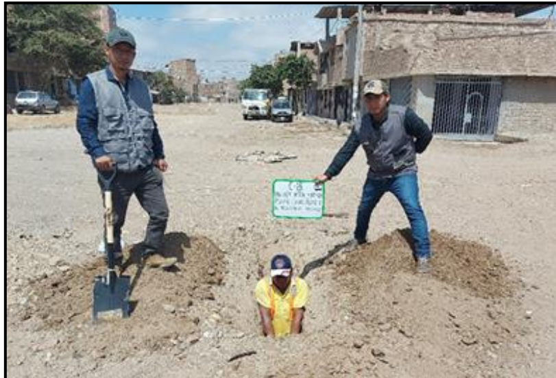
FOTO N° 8: CALICATA N°08.- Ubicada en la Intersección de Av. Rio Ayaviri con calle NN -234 -Coordenadas 9252473.42 N-625317.445 E
