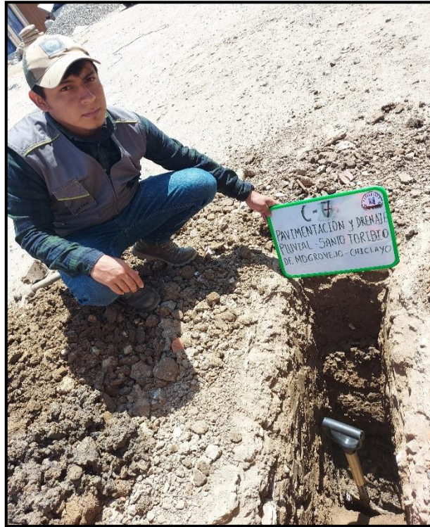
FOTO N° 7: CALICATA N°07.- Ubicada en la Intersección de Pasaje NN-49 con Pasaje NN-51 -Coordenadas 9252197.164 N-625318.391 E
