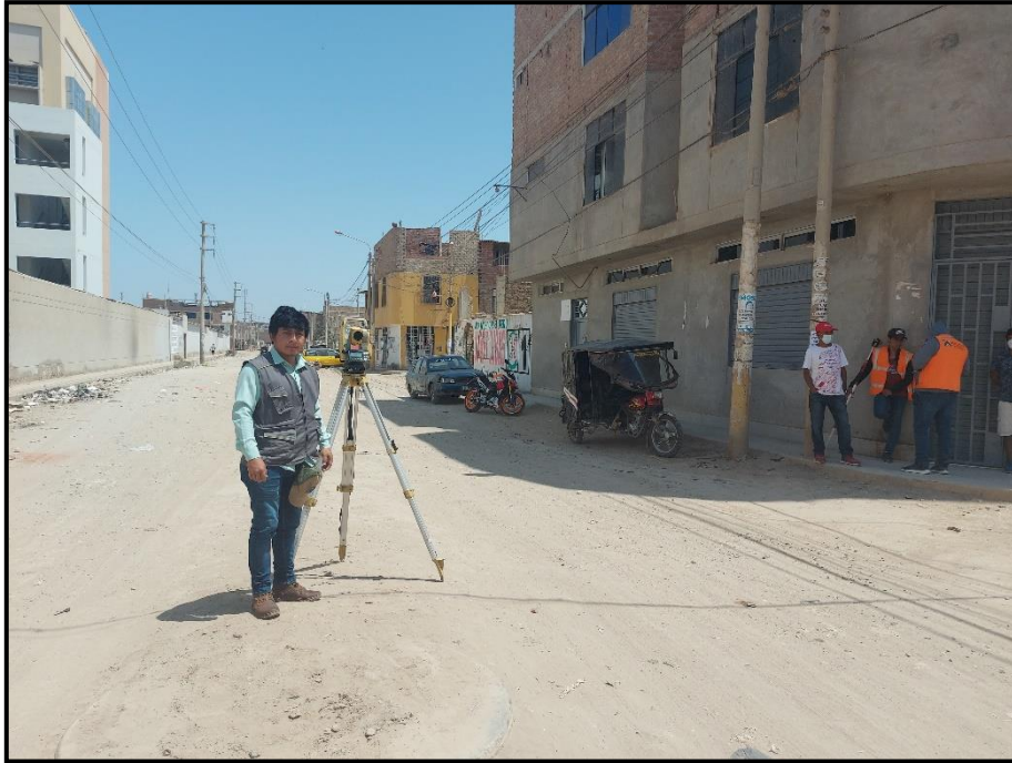
FOTO N° 9: Levantamiento topográfico Av. Rio Ayaviri, parte posterior de la Universidad Santo Toribio de Mogrovejo.
