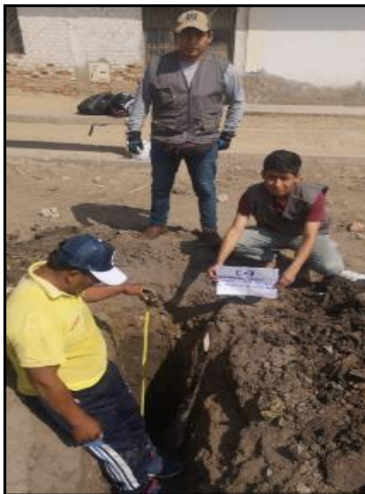
FOTO N° 9: CALICATA N°09.- Ubicada en la Calle NN - 236 -Coordenadas 9252222.289 N-625420.445 E
