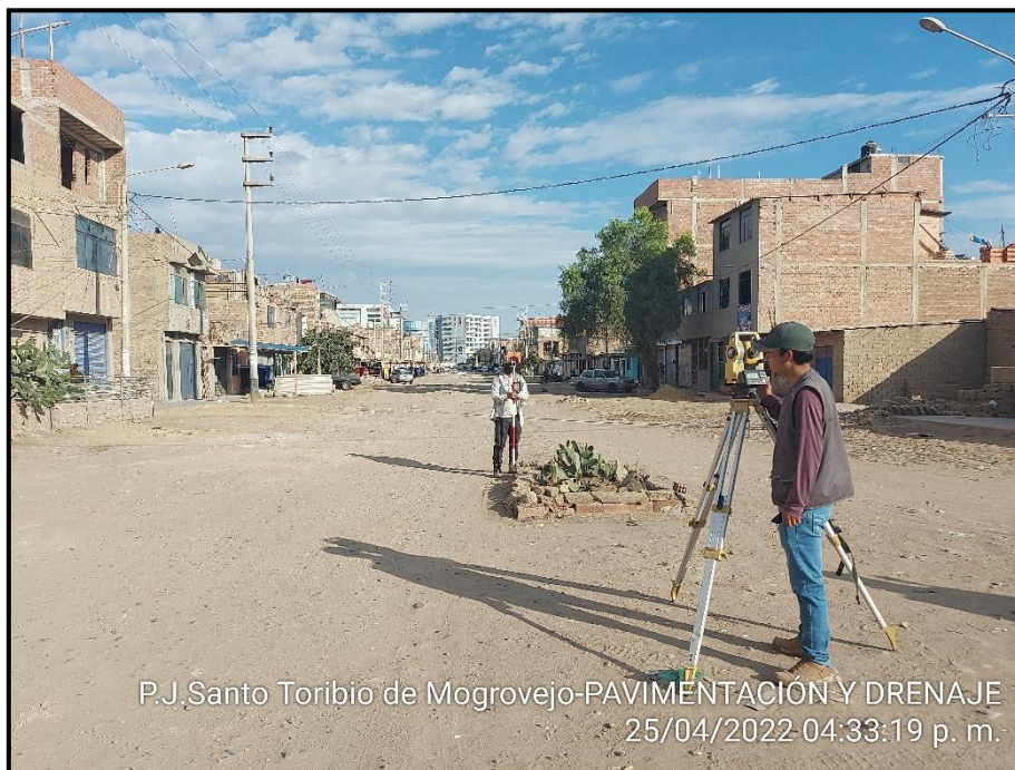
FOTO N°18: Levantamiento topográfico en otro punto de la Av. El Progreso
