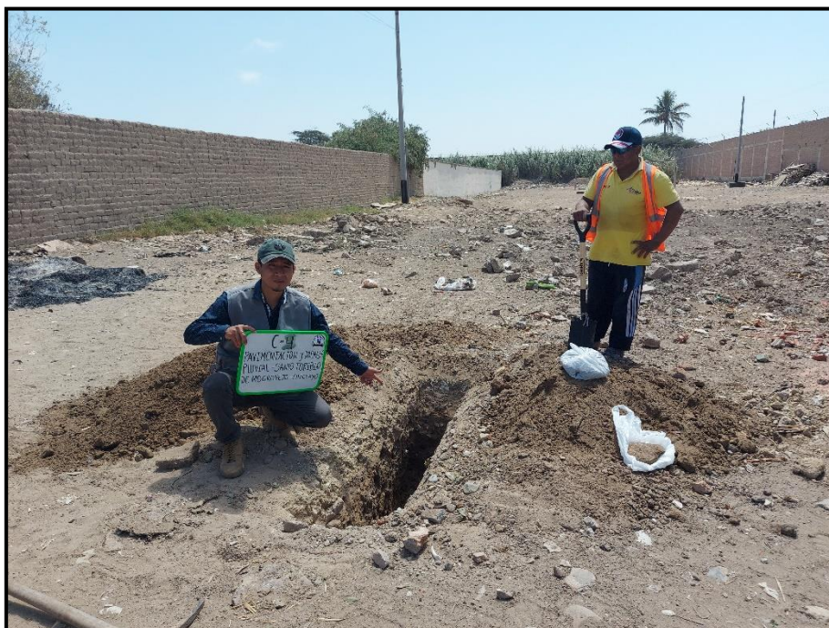
FOTO N° 4: CALICATA N°04.- Ubicada en la Avenida El Progreso - Coordenadas 9252858.16 N-625393.26 E
