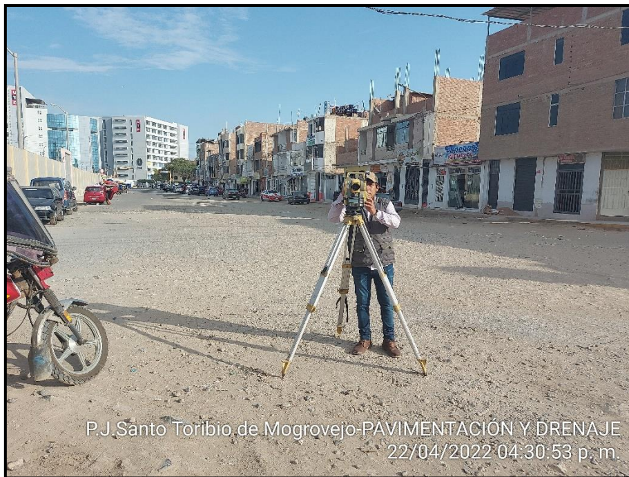
FOTO N° 8: Levantamiento topográfico Av. El Progreso, Próximo al hospital regional de Lambayeque
