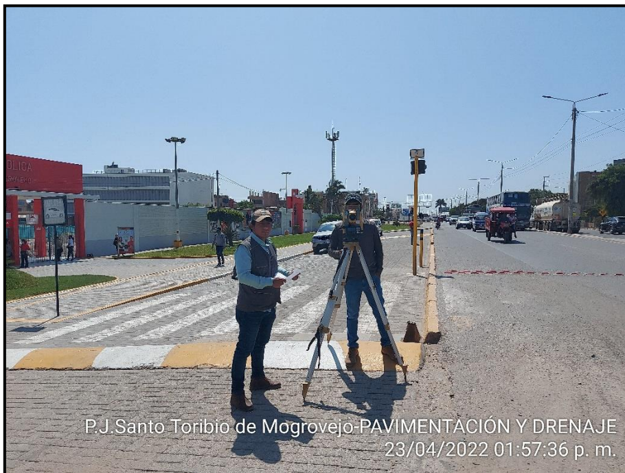
FOTO N° 14: Se aprecia el estableciéndose en una nueva estación en la Panamericana Norte.
