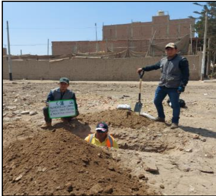
FOTO N° 15: CALICATA N°15.- Ubicada en la Intersección de Av. Rio Ayaviri con calle NN -242 -Coordenadas 9252575.796 N-625486.743 E
