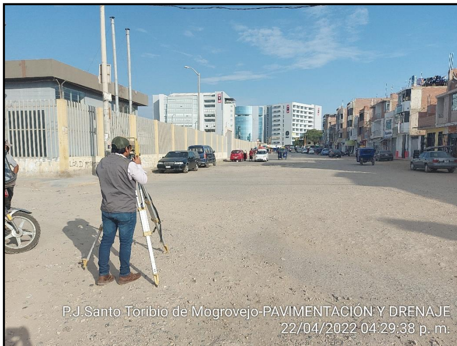
FOTO N° 6: Levantamiento topográfico Av. El Progreso, Próximo al hospital regional de Lambayeque
