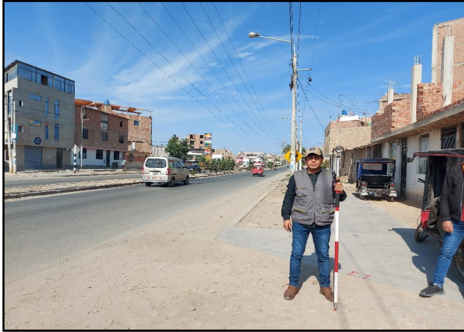
FOTO N°03: Inicio del levantamiento topográfico próximo a la vía de evitamiento
