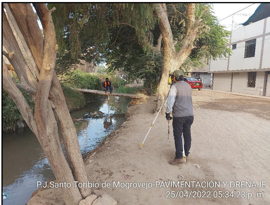
FOTO N°21: Toma de puntos en los bordes de la acequia Cois.
