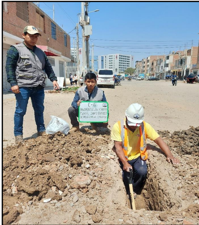
FOTO N° 6: CALICATA N°06.- Ubicado en la intersección de Av. El Progreso con calle NN - coordenadas N:9252410.60 - E: 625470.14
