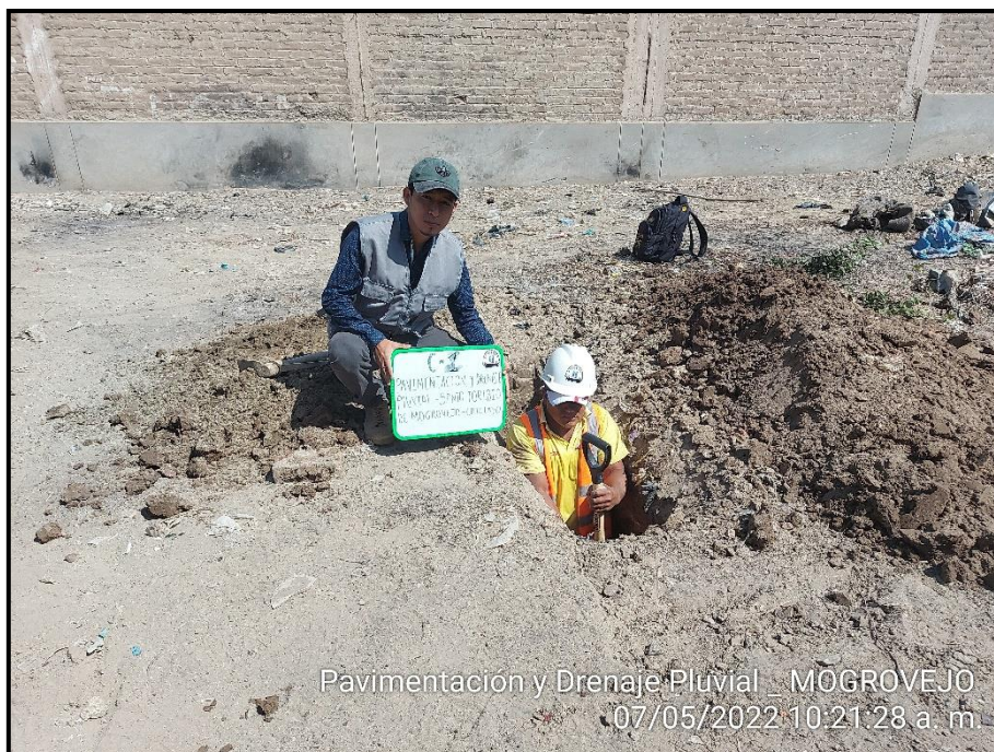
FOTO N° 2: CALICATA N°02.- Ubicado en la Intersección de calle Rio Ramis con calle Rio Grande, coordenadas N: 9252783.751, E: 625618.687
