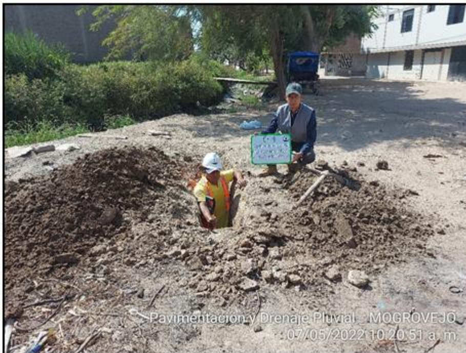
FOTO N° 1: CALICATA N°01.- Ubicado en la avenida El Progreso, coordenadas N: 9252832.445-E: 625527.122
