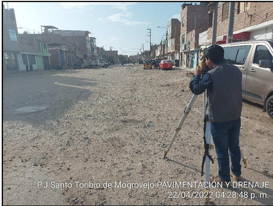
FOTO N° 5: Levantamiento topográfico Av. El Progreso
