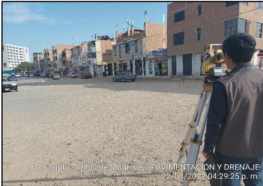
FOTO N° 7: Levantamiento topográfico Av. El Progreso, Próximo al hospital regional de Lambayeque
