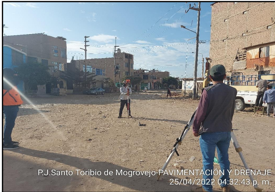
FOTO N° 17: Levantamiento topográfico en otro punto de la Av. El Progreso
