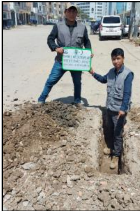
FOTO N° 14: CALICATA N°14.- Ubicada en la Intersección de calle NN - 239 con calle NN - 246 -Coordenadas 9252321.356 N-625455.172 E
