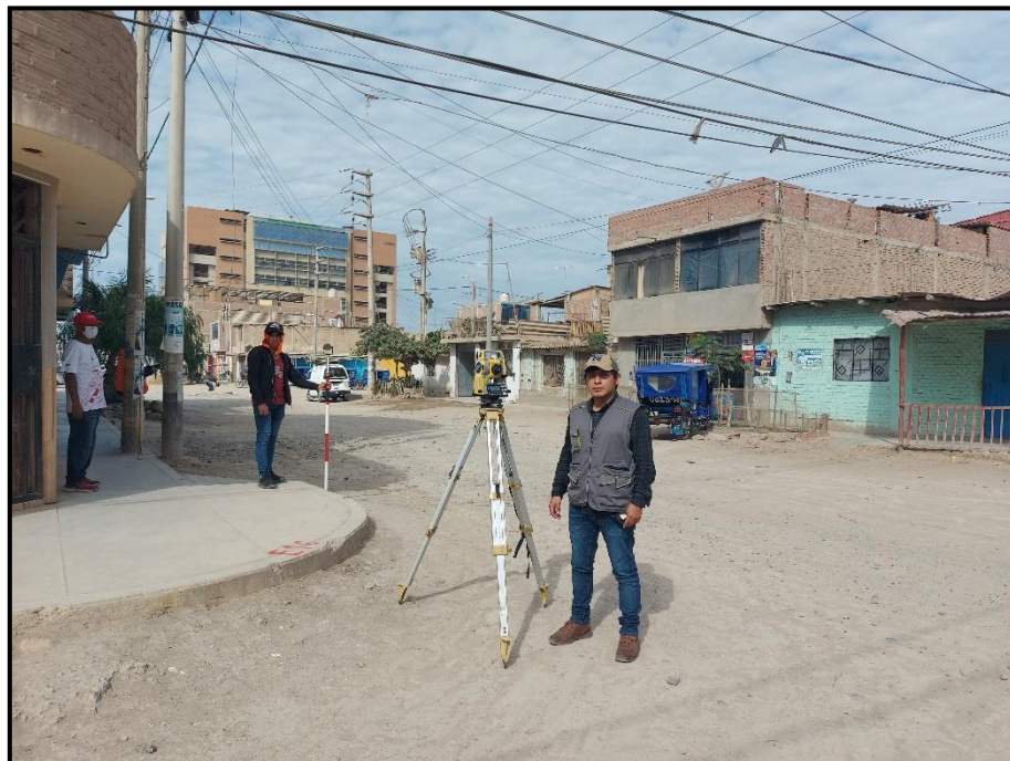
FOTO N° 4: Levantamiento topográfico intersección de la Av. Rio Ayaviri y calle CALLE NN - 239
