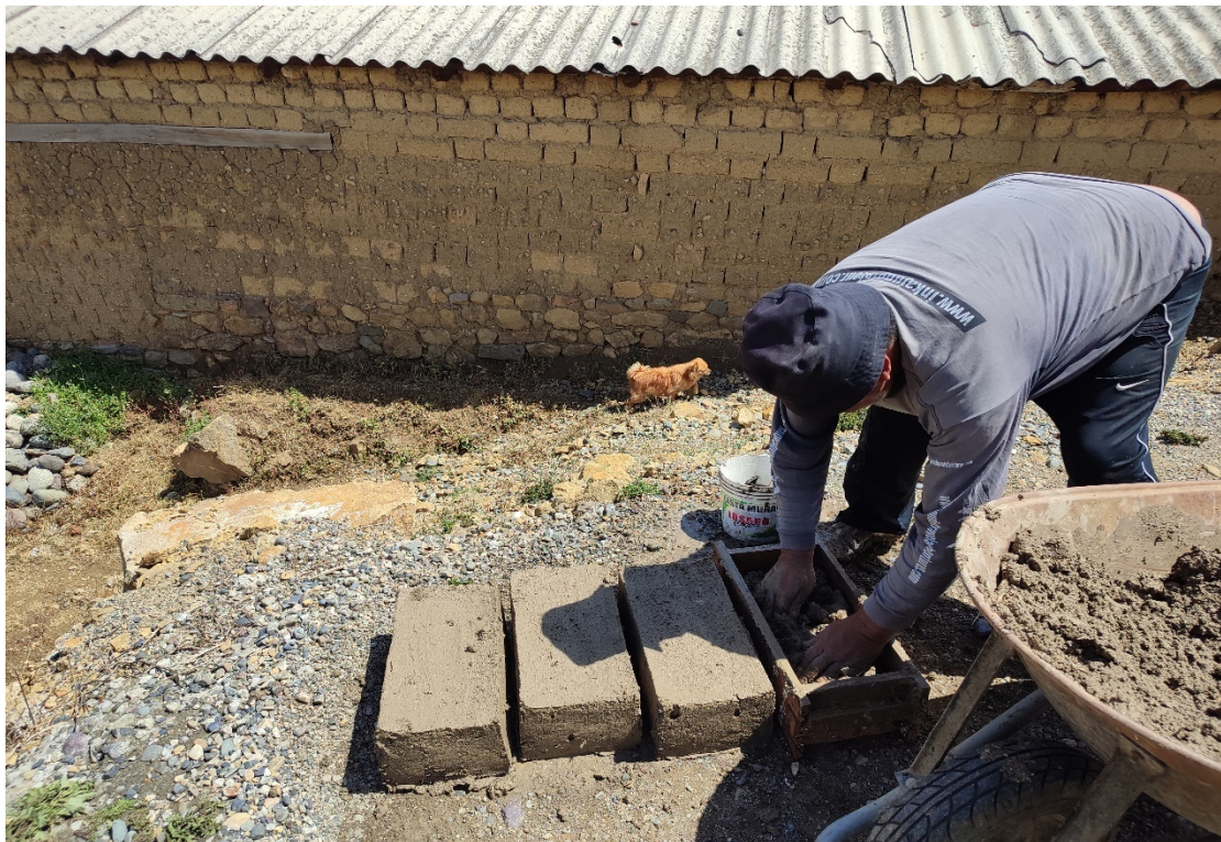
Fig. 17. Colocación de Porcentaje de Tierra mezclada en adoberas.
