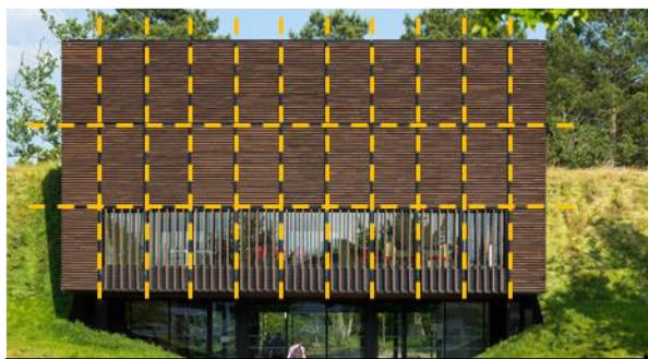
Imagen 4. Fachada con malla reticular.
