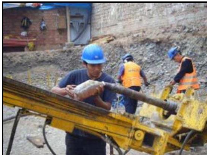
Figura 9. Colocación de lubricante
