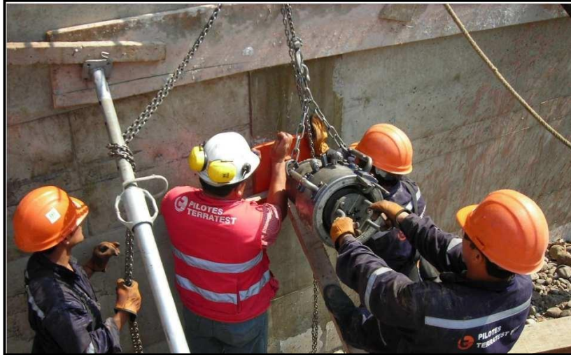
Figura 19. Tensado de anclajes
