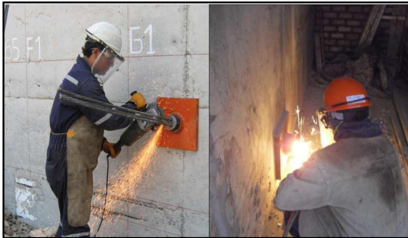
Figura 20. Destensado de anclajes
