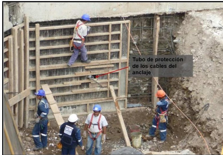
Figura 16. Encofrado de muro anclado
