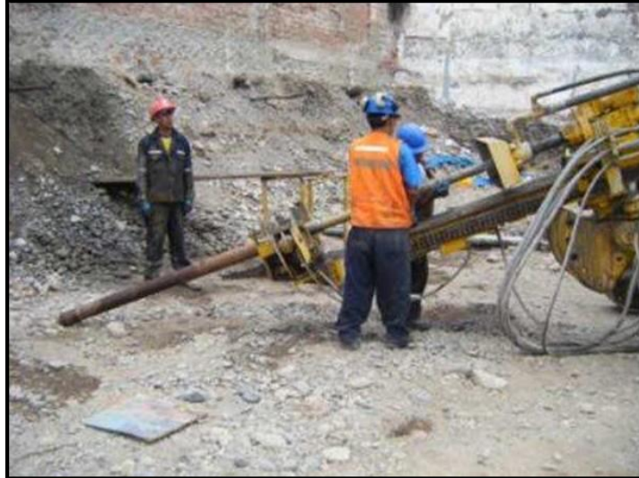
Figura 8. Armado de taladro y casing
