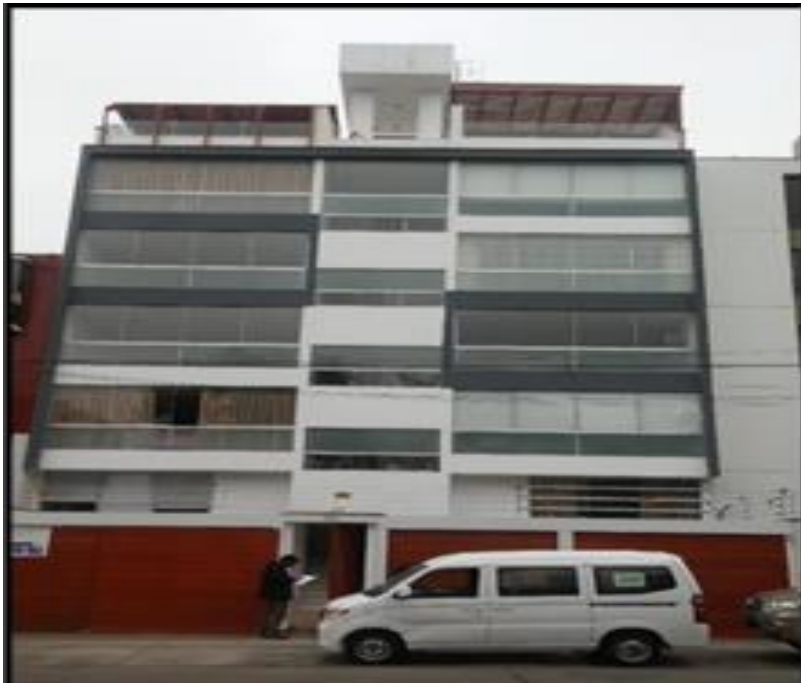
Edificio Multifamiliar construido con el sistema de calzaduras
