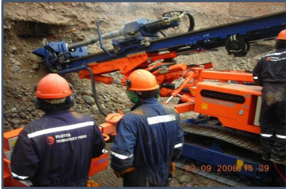
Figura 26. Perforación muros anclados
