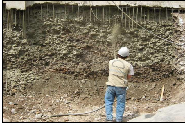
Figura 14. Pañeteo de talud con lechada de concreto
