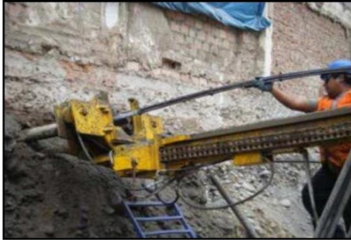
Figura 12. Inserción de cables para tensado
