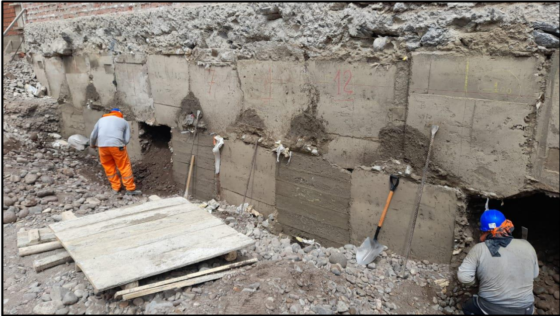
Figura 4. Encofrado y desencofrado de Calzadura
