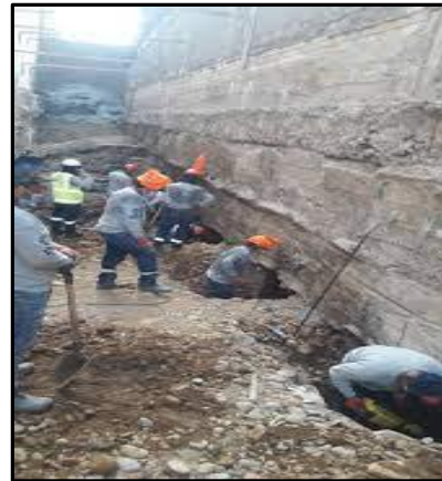
Figura 27. Excavación calzadura.
