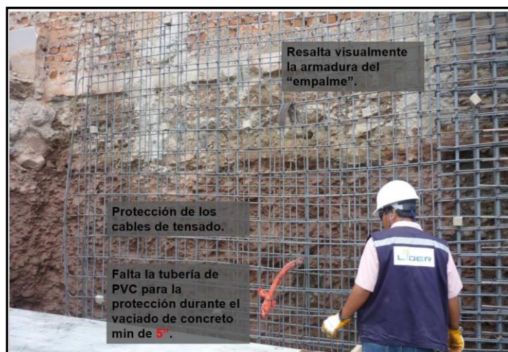
Figura 15. Colocación de enmallado de acero
