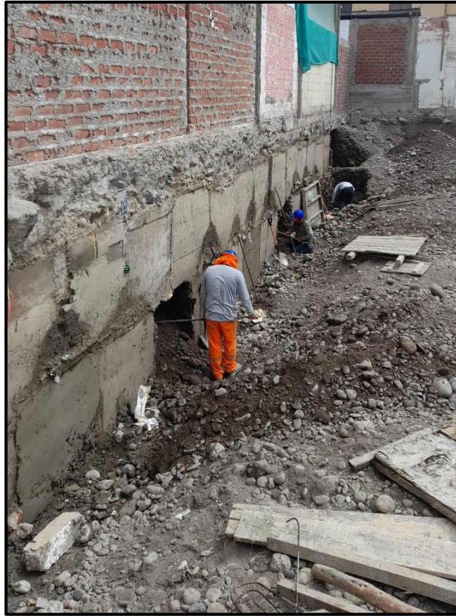
Figura 3. Excavación Manual de Calzadura
