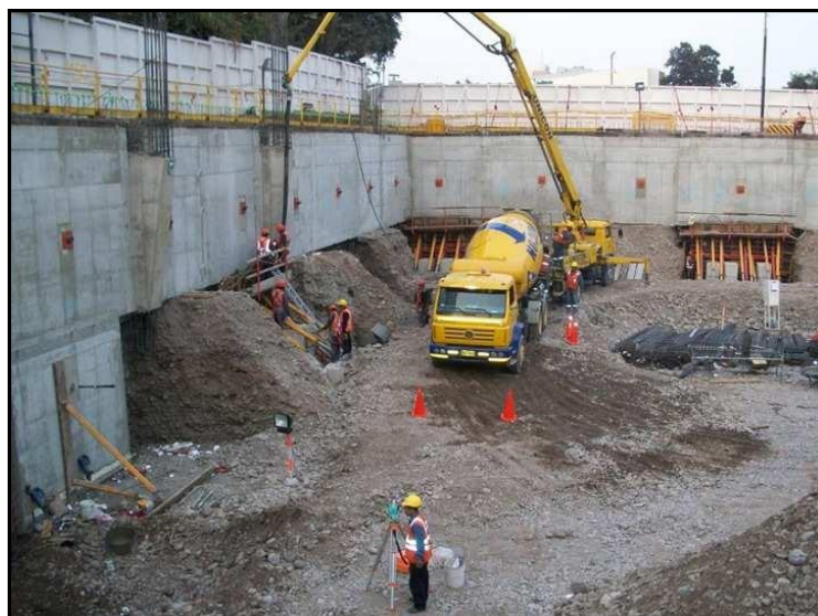
Figura 17. Vaciado de muro anclado
