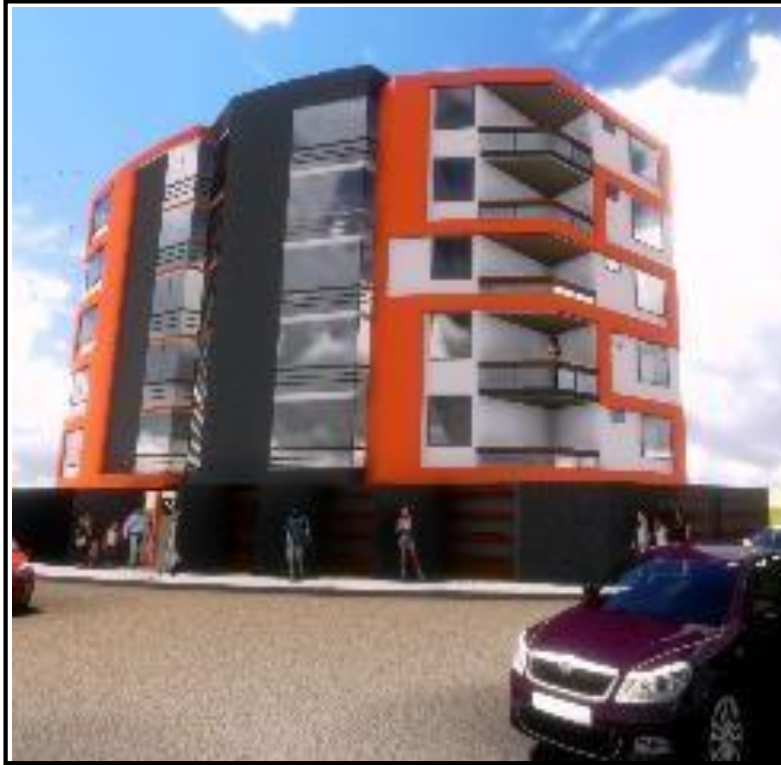
Edificio Multifamiliar construido con el sistema de muros anclados
