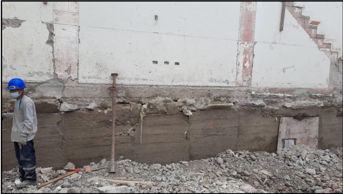
Figura 5. Vaciado de Calzadura
