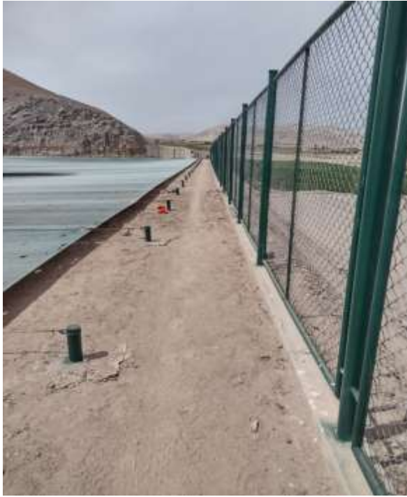
Imagen 11. Parte lateral del reservorio
