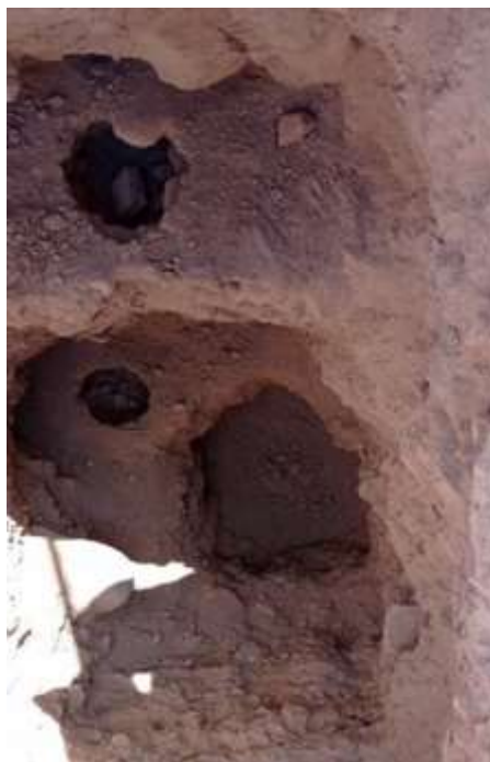
Imagen 28. Calicata 02 al lado del reservorio
