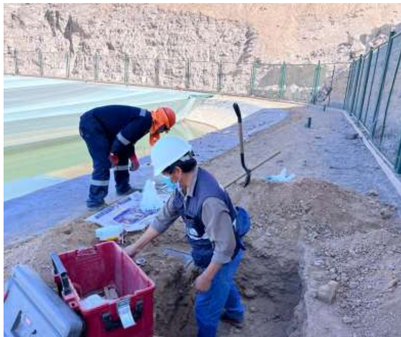
Imagen 16. Calicata 01 en la corona del reservorio.
