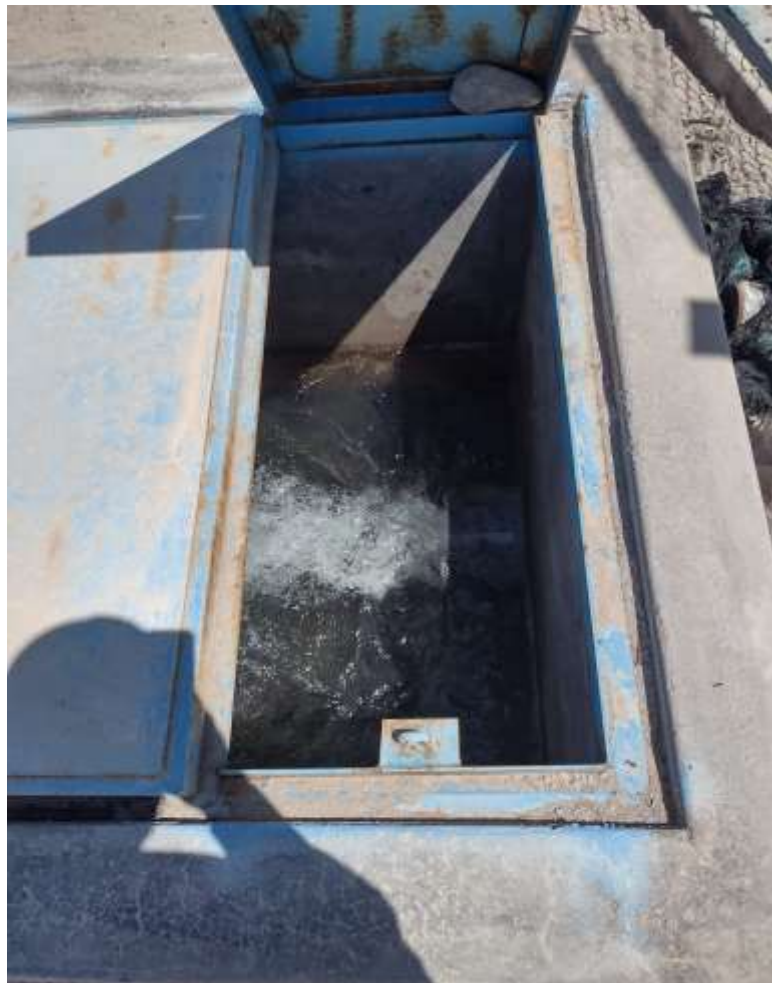
Imagen 10. Entrada del caudal al reservorio
