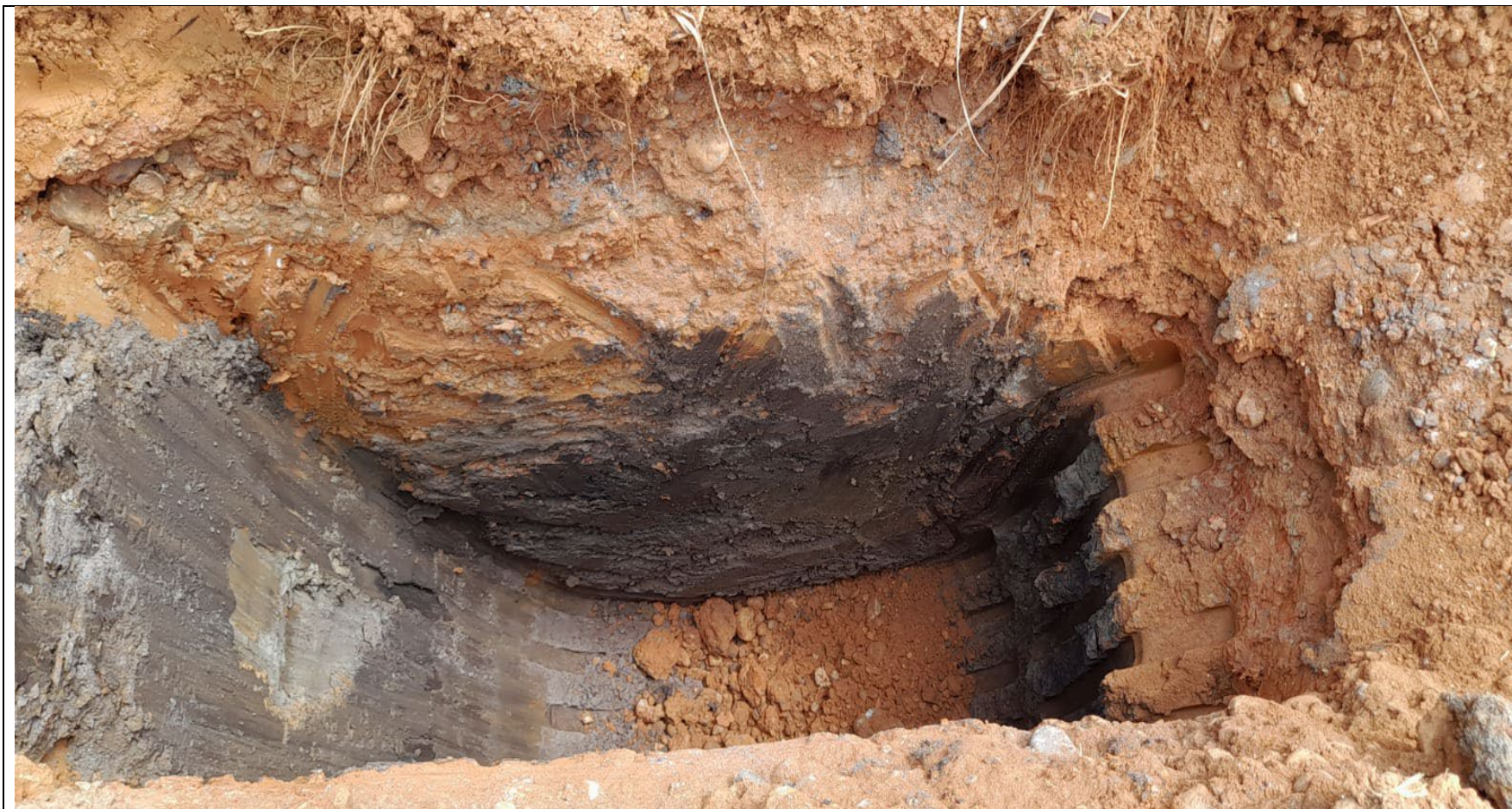
FOTO 01: EN LA CALICATA SE APRECIA SUELO SATURADO.
