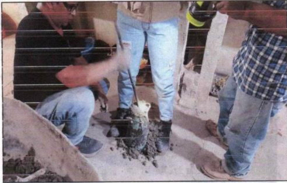
Realización de medición del ensayo de asentamiento "SLUMP" de 6" a 7" HORMIGÓN (CONCRETO). Método de ensayo para la medición del asentamiento del concreto de cemento Portland - NTP 339.035 - 2009.
