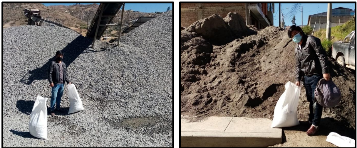
Figura 18. Adquisición de agregados de la cantera de Tacllan – Rio Santa
