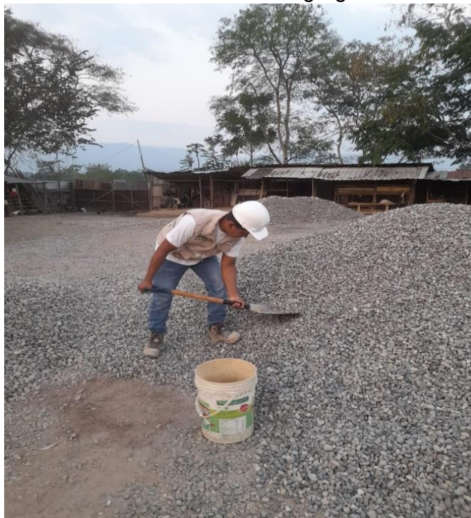
FOTO N°02: Extracción del Agregado Grueso.
