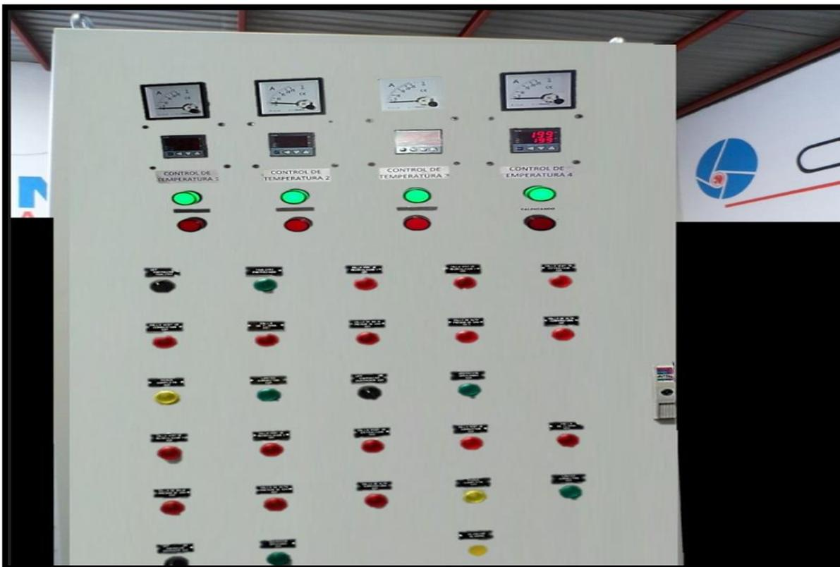
FOTOGRAFIA 7 Tablero mostrando la temperatura de incineración de la cáscara
