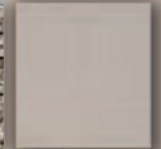
Acabado tarrajado y pintado
