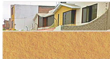
Acabado en tarrajeo y pintado color mostaza
