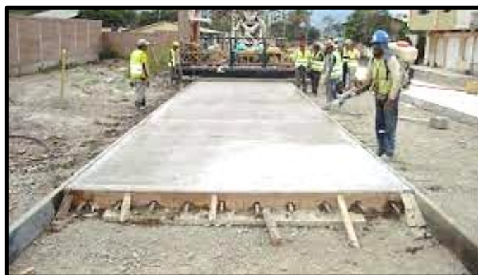
Figura 3. Proceso de construcción de un pavimento rígido
