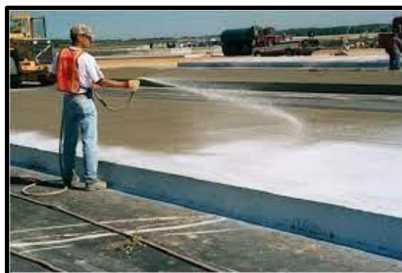
Figura 2. Curado de concreto en un pavimento rígido
