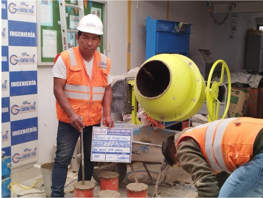
Fotografía 7. Colocando la mezcla de concreto en los moldes
