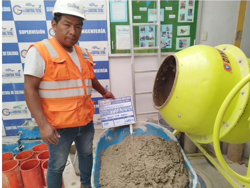
Fotografía 5. Realizando la mezcla de concreto y control de temperatura
