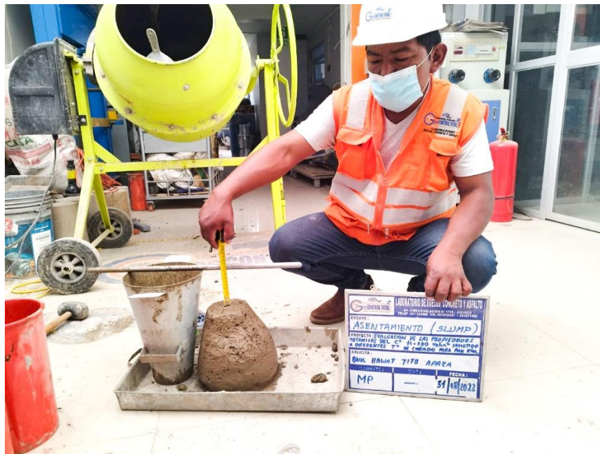
Fotografía 6. Controlando la trabajabilidad del concreto mediante el cono de Abrams
