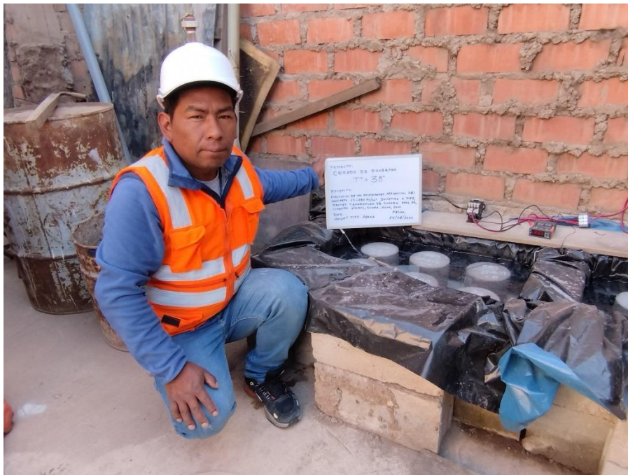
Fotografía 8. Controlando el curado del concreto en 38°C
