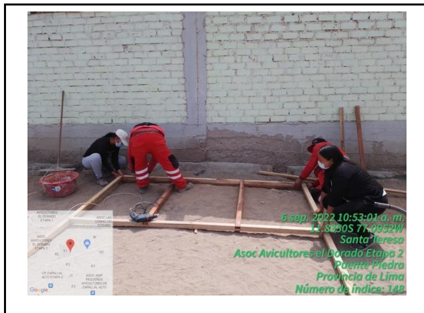
Figura 7. Elaboración del marco de soporte
