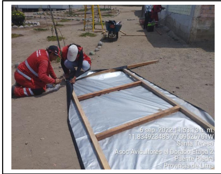
Figura 8. Colocando la capa impermeable
