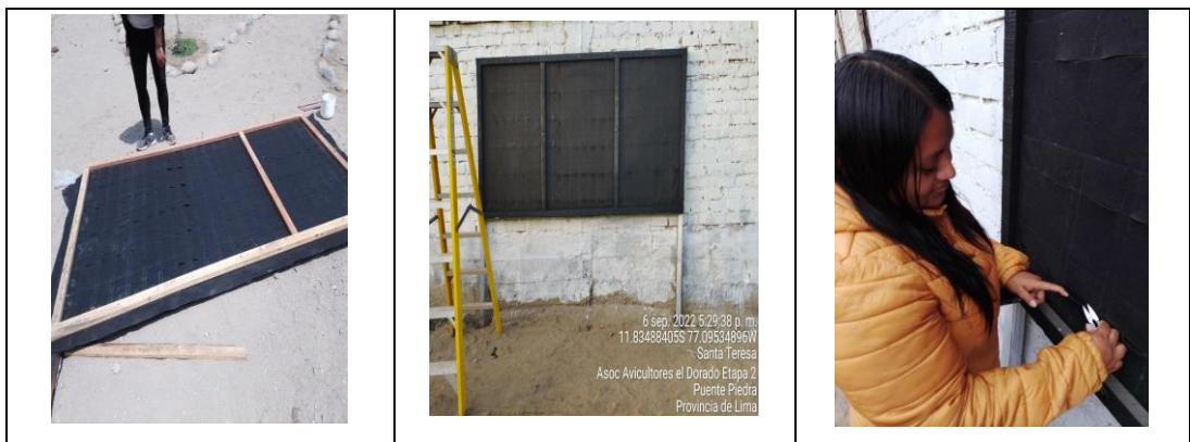
Figura 9. (a) Colocando la capa de fieltro, (b) Estructura fijada y (c) Corte de bolsillos
