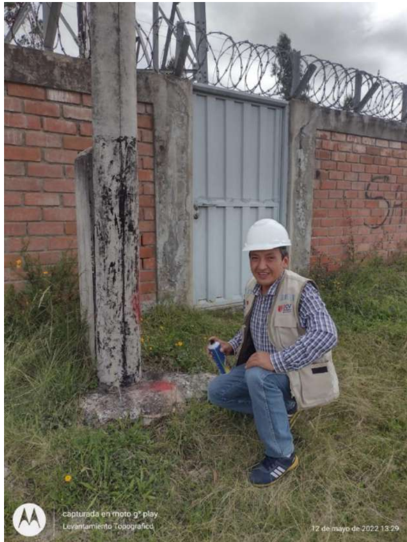
Foto 5: Marcación de puntos de cambio de estación.
