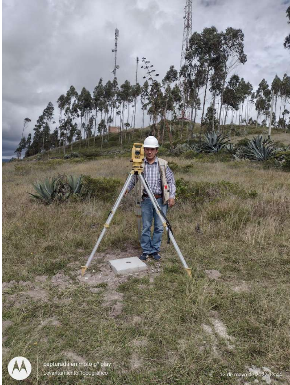
Foto 1: Inicio de trabajos en Punto Georreferenciado
