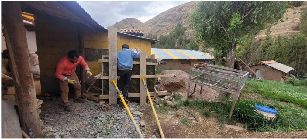
Asegurando los encofrados con el alambre.
