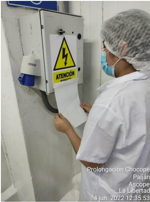
Figura 7 Evidencia del pegado de señaléticas
