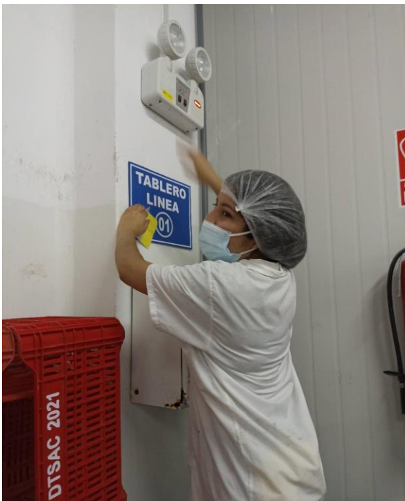
Figura 8 Evidencia del pegado de señaléticas
