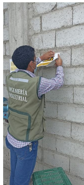
Figura 2 Evidencia del pegado de señaléticas
