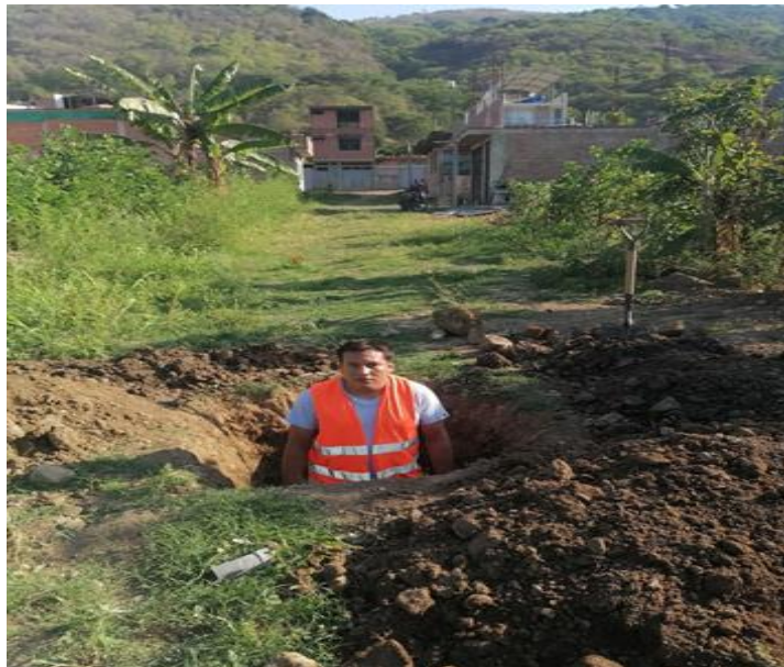
Foto 4. Proceso de Excavación de calicata
