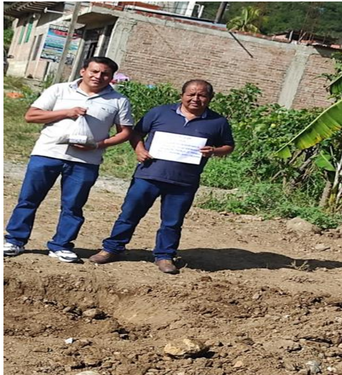
Foto 3. Proceso de Excavación de calicata
