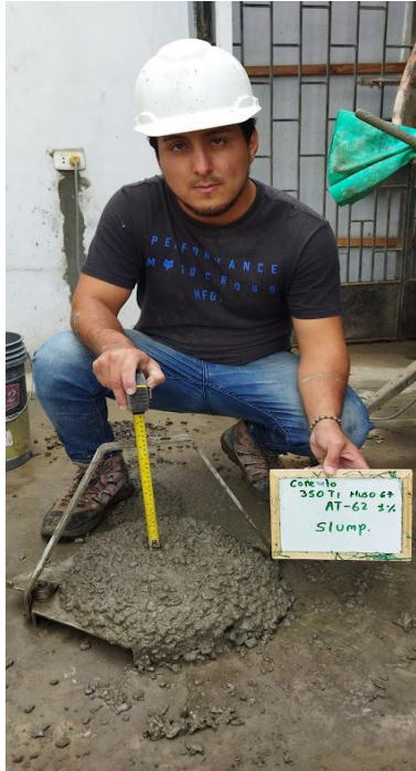
Figura 39. Ensayo del concreto en estado fresco SLUMP
