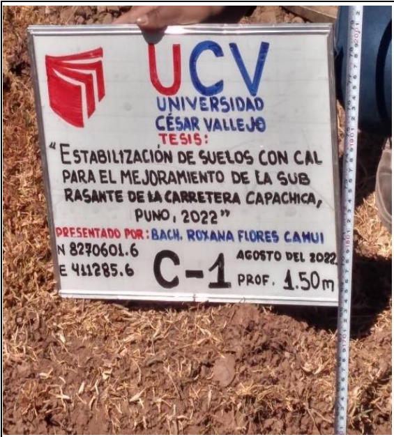
Figura 21 Datos de la calicata 1 a 100m del inicio de la carretera.
