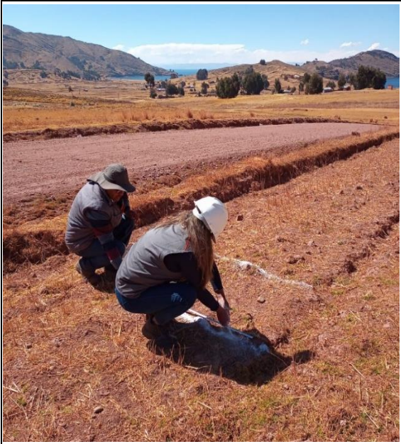
Figura 19 Enmarcado de calicatas en la carretera Capachica a Chifron.
