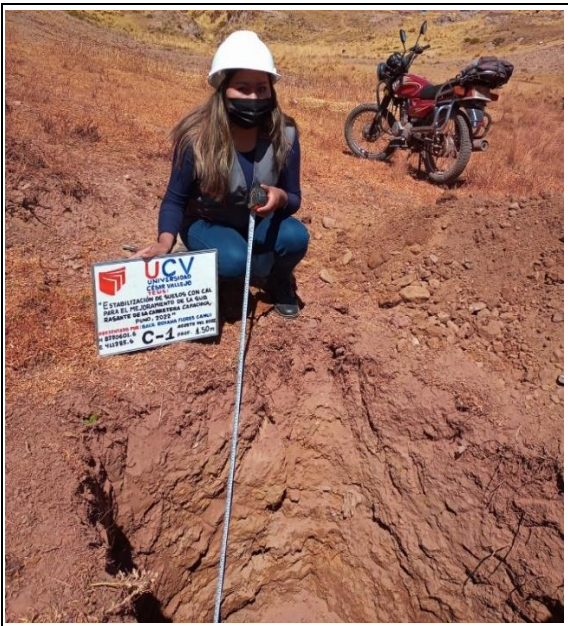
Figura 20 Excavación de calicata 1 en la carretera Capachica a Chifron.
