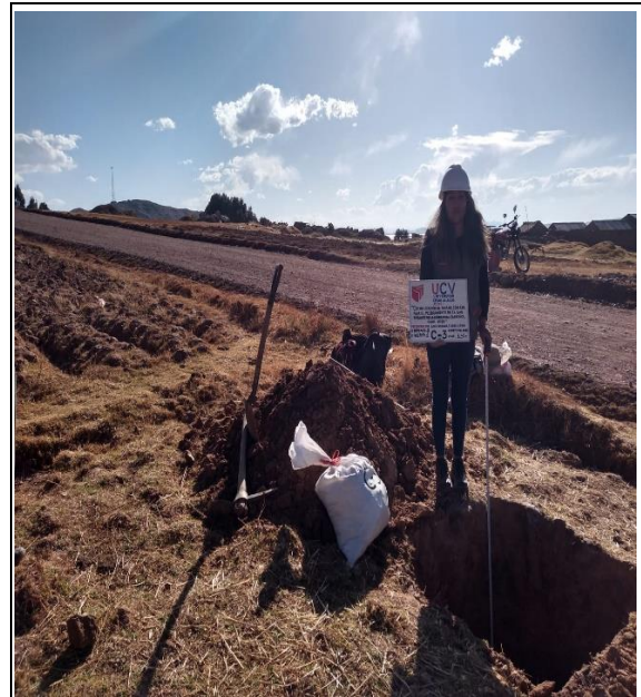
Figura 24 Excavación de la calicata 3 en la carretera Capachica a Chifron.
