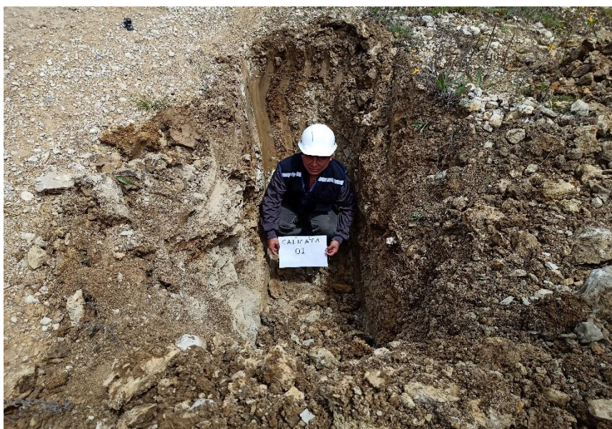
Figura 10: Extracción de muestra de la Calicata N°01
