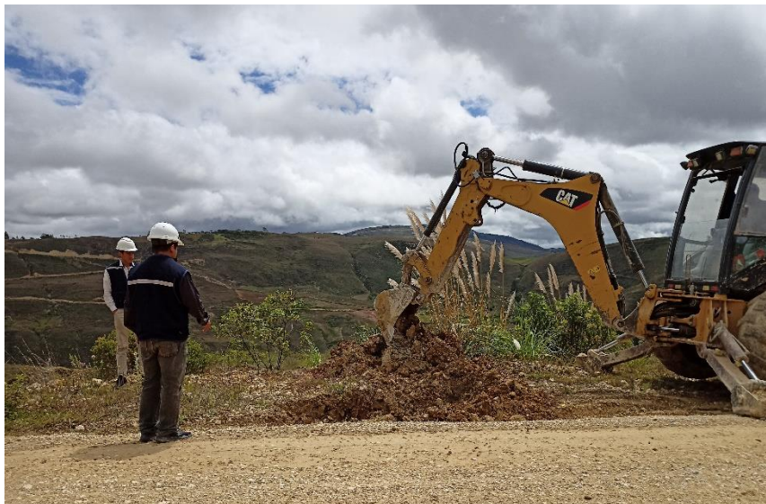
Figura 9: Excavación de calicata para extracción de muestra
