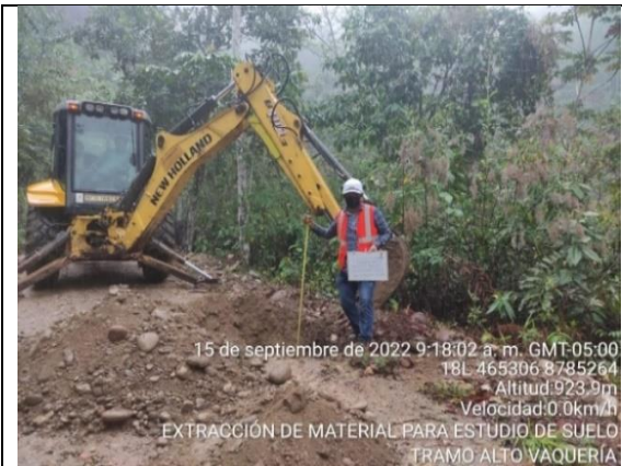
Calicata 03 del km 00+500 del sector Alto Vaquería
