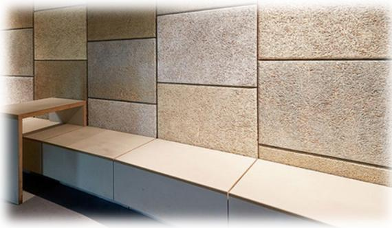
Utilización de elementos de control acústico como el enchape de baldosa acústica en pisos, paredes y falso cielo raso en techos.
