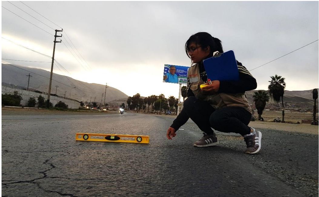
Figura 62. Verificación de la ccorrugación
