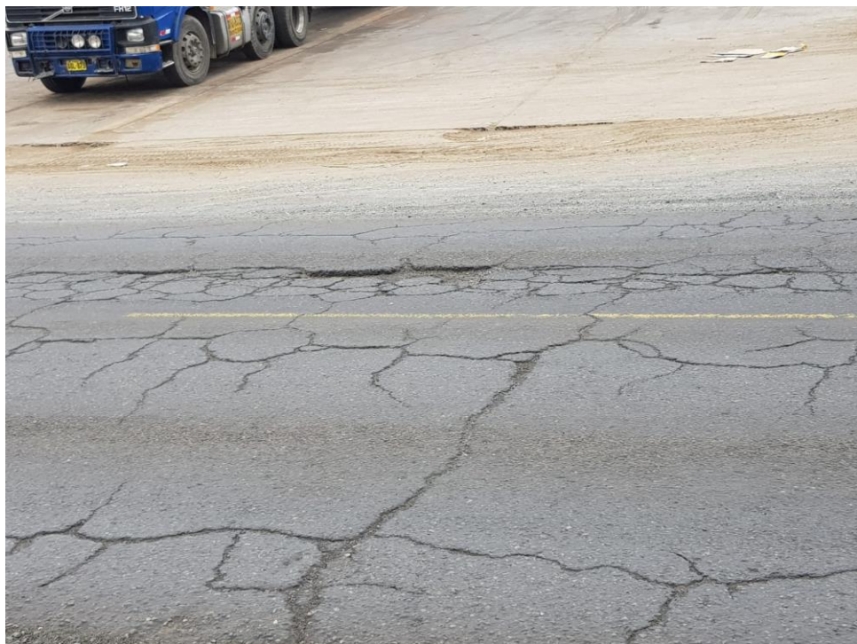
Figura 57. Agrietamiento en bloque severidad alta
