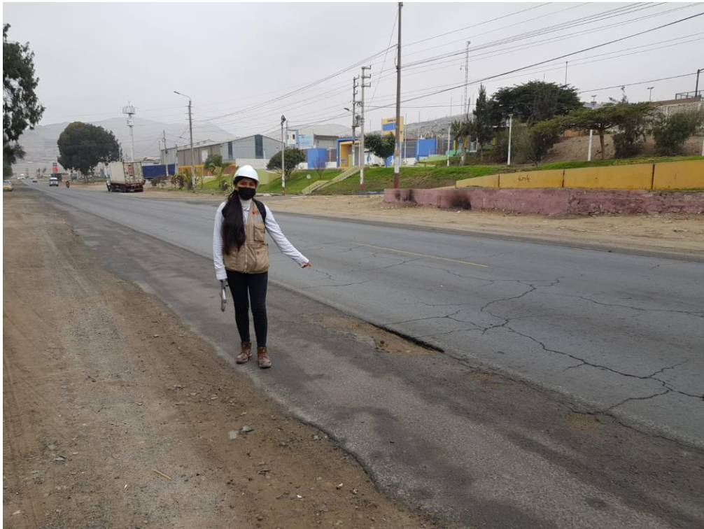
Figura 57. Agrietamiento en bloque severidad alta
