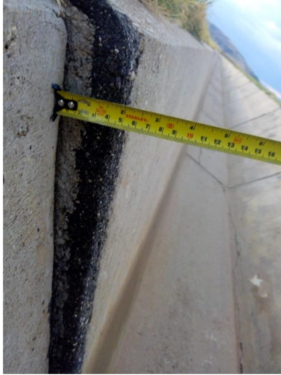
Figura 7: Asentamiento de 5cm.
