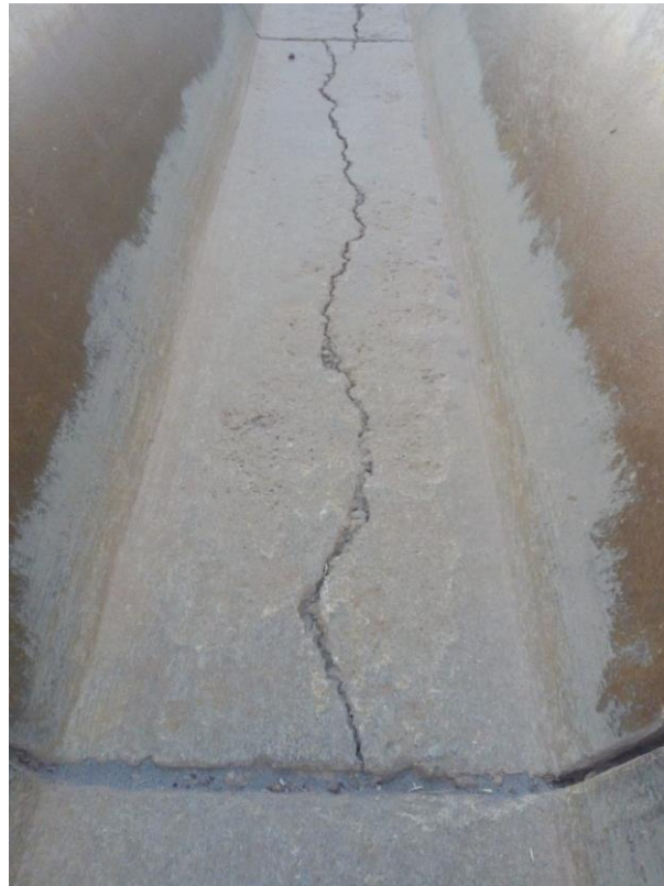
Figura 8: Grietas longitudinales.
