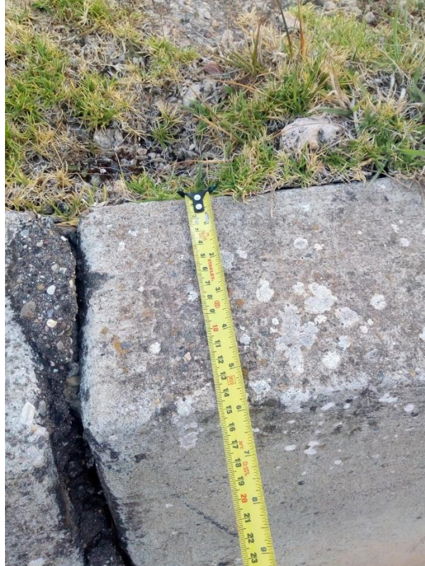
Figura 21: Espesor de canal y separación de junta
