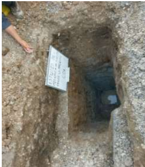
Figura N° 05: Ejecución de calicata Fuente: Elaboración propia
