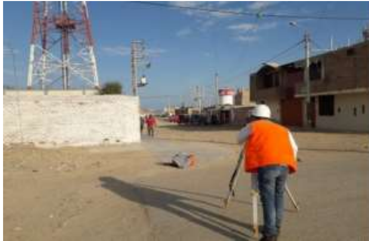
Figura N° 06: Toma de datos en el levantamiento topográfico
