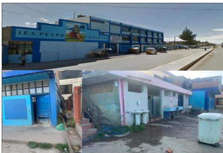
Institución educativa Pedro Vilcapaza: condición de infraestructura
