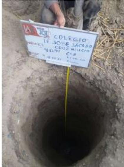
Figura 6. La toma corresponde al fondo de la calicata asignada como C-5. La excavación se detuvo a la profundidad de 4.80m debido a la presencia de Napa Freática.
