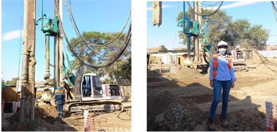
Figura 4. Aplicación de la columna de grava mediante la perforación del suelo.
