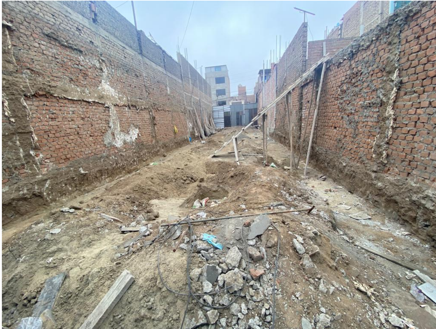
Figura 95: Visita terreno del centro comercial
