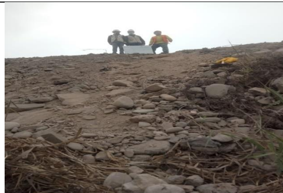
Imagen 12: Toma de muestra calicata 2
