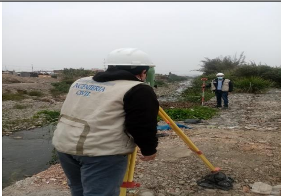
Imagen 7. Uso de estación total
