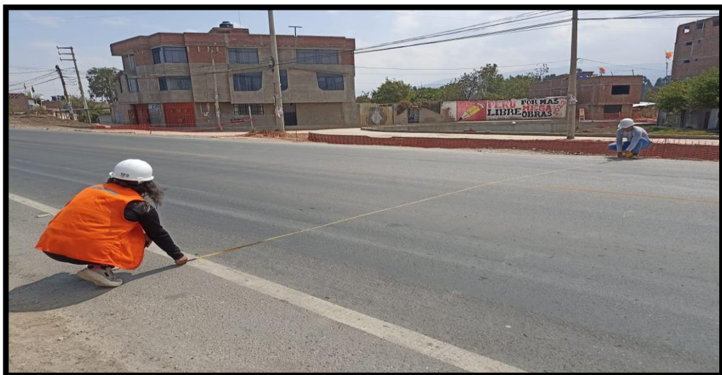
FOTOGRAFIA 8: Tomando la medida de las condiciones geométricas de la vía: sección transversal de la intersección Las Américas y Francisco Bolognesi
