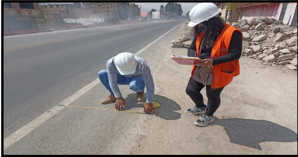
FOTOGRAFIA 7: Tomando la medida de las condiciones geométricas de la vía: ancho de hombrera o berma de la intersección Las Américas y Francisco Bolognesi
